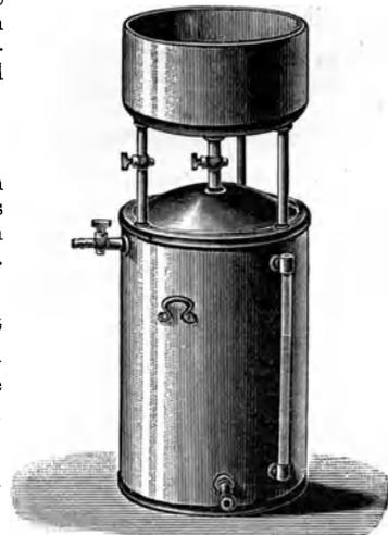
Abb. 10. Gasometer aus Blech.
