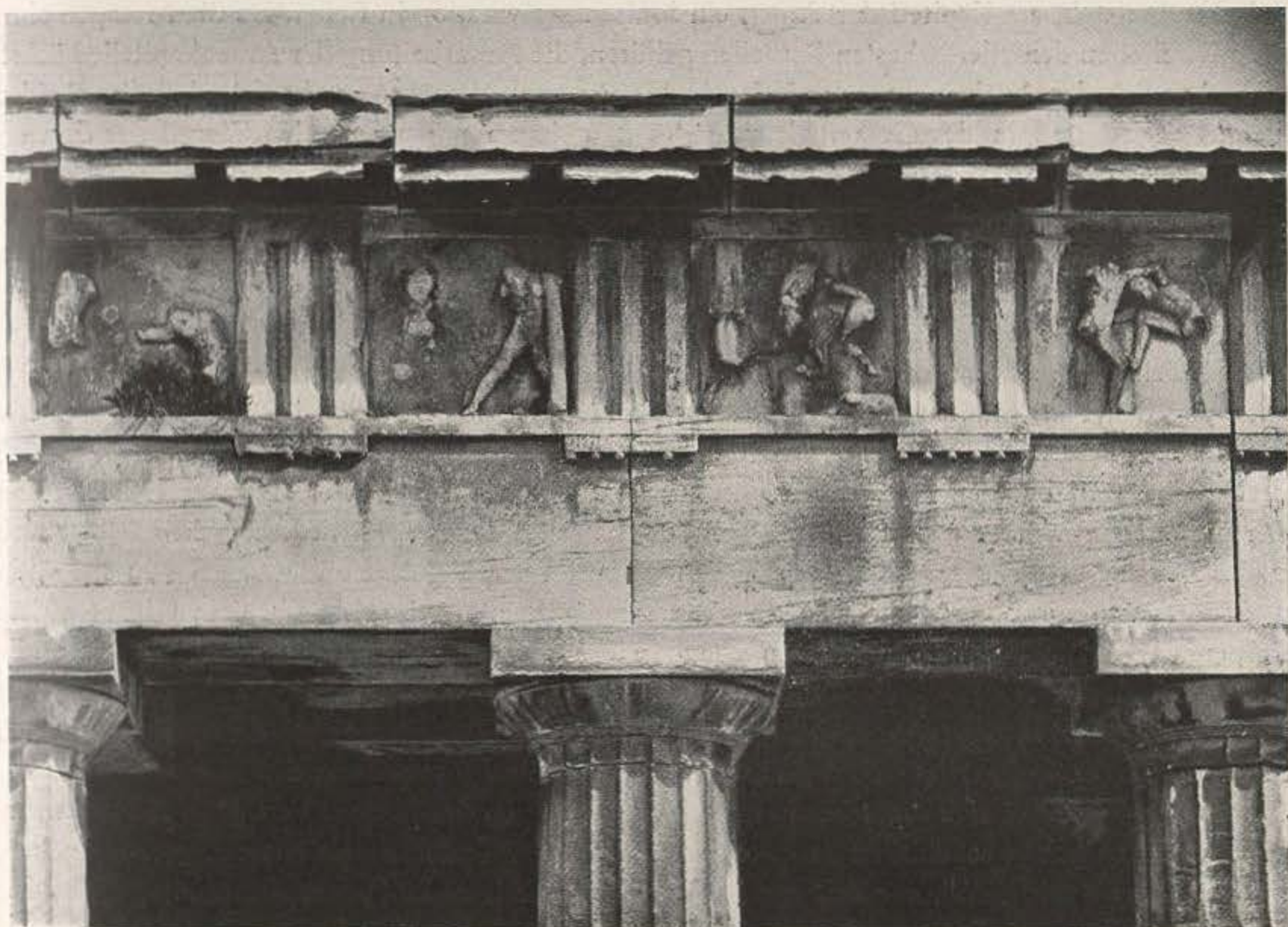
196. Gebälk des „Theseion“, Südseite
