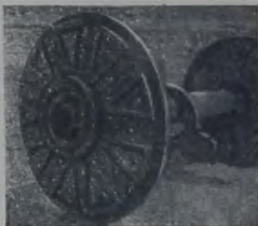
Рис. 291. Излом бортового вала парохода „Чкалов“ из-за насадки колесного диска в горячем состоянии.
