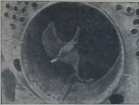
Рис. 467. Вид с фасада топки котла парохода „Лев Толстой“ после взрыва.
