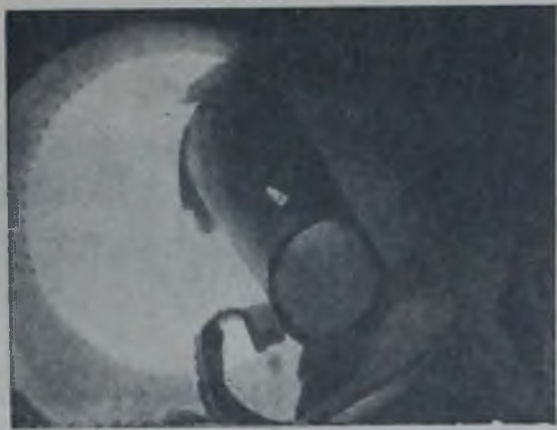
Рис. 468. Вид топки котла парохода „Лев Толстой“ (после взрыва, снимок сделан из огневой камеры).
