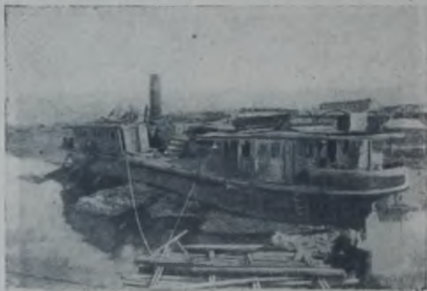
Рис. 472. Характер разрушения парохода «Лев Толстой» от взрыва котла.
