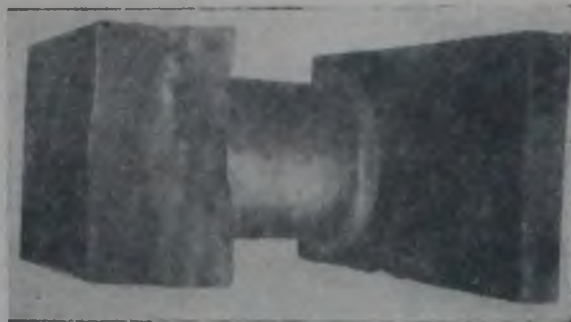
Рис. 364. Излом коленчатого вала дизеля силовой станции затона им. Ульянова-Ленина.
