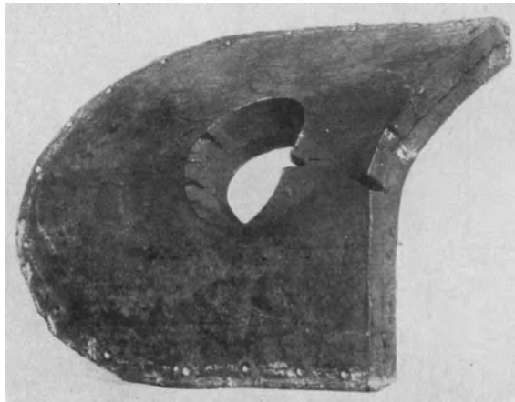
Abb. 43. Nietloch- und Kantenrisse.
