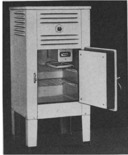
Abb. 4. Haushaltkühlschrank mit Absorptionsmaschine, Protos-Frigor (S. S. W.).
