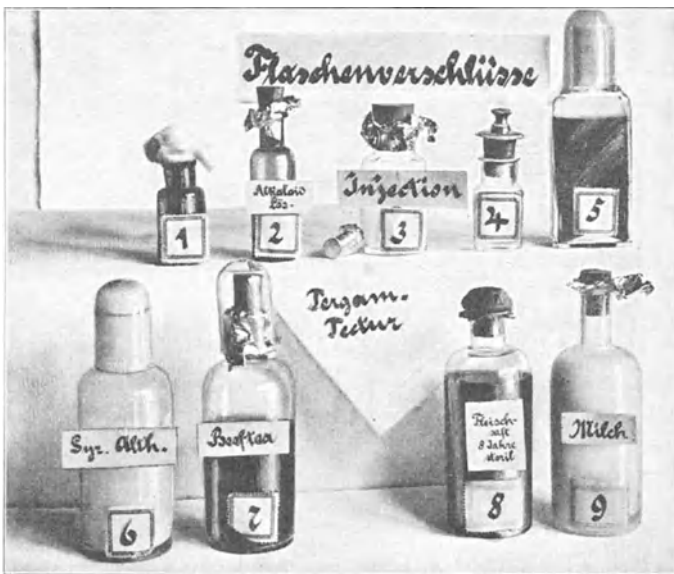
Abb. 56. Verschlüsse für Sterilisationsflaschen.
