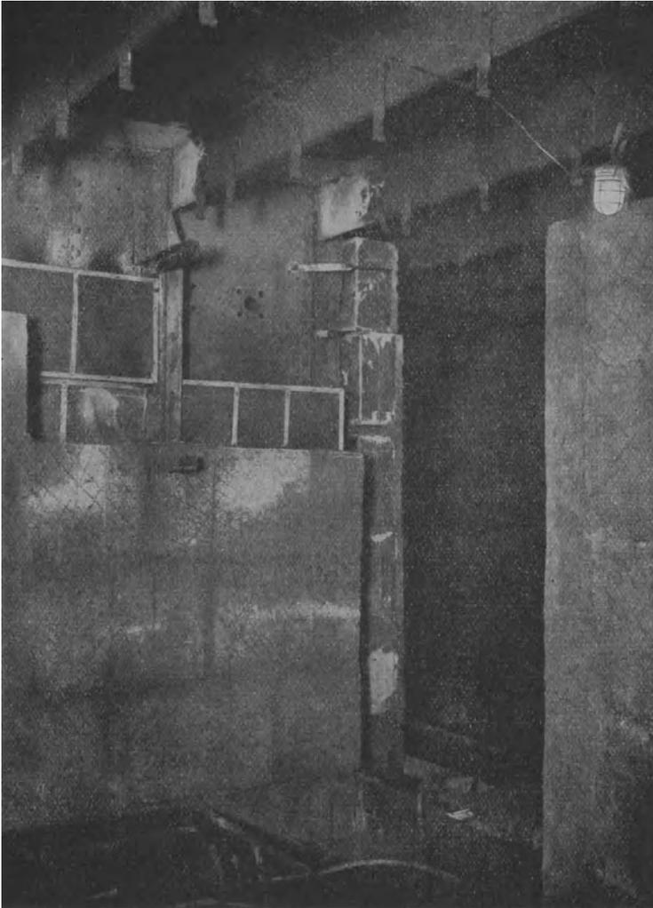
Fig. 10. Selbständige Thermosbauwand in einem Schiffskühlraum
