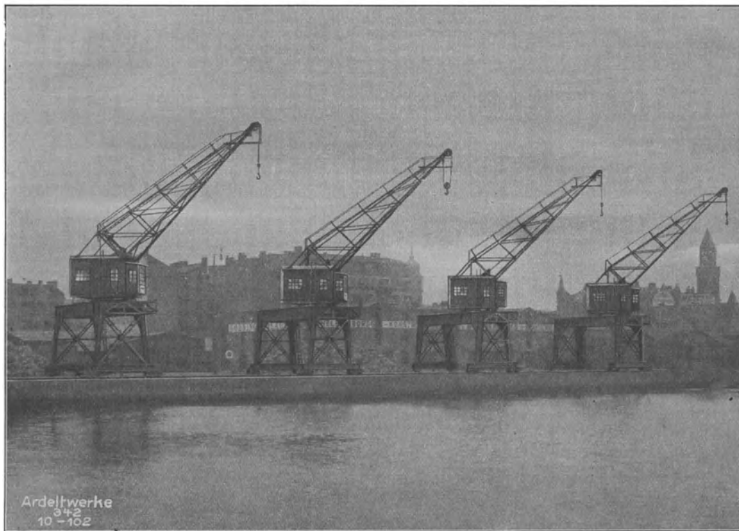
Abb. 4. Elektrisch betriebene Vollportalkrane.
