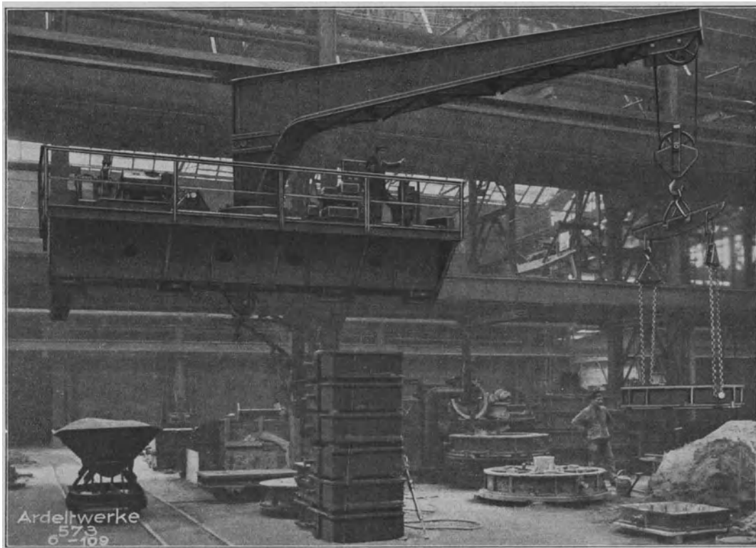
Abb. 12. Elektrisch betriebener fahrbarer Konsoldrehkran.
