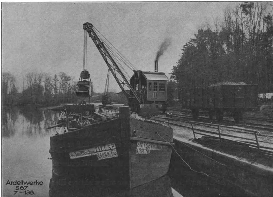
Abb. 25. Normaler Ardelt-Lokomotiv-Greifer-Dampfkran beim Entladen von Kähnen.
