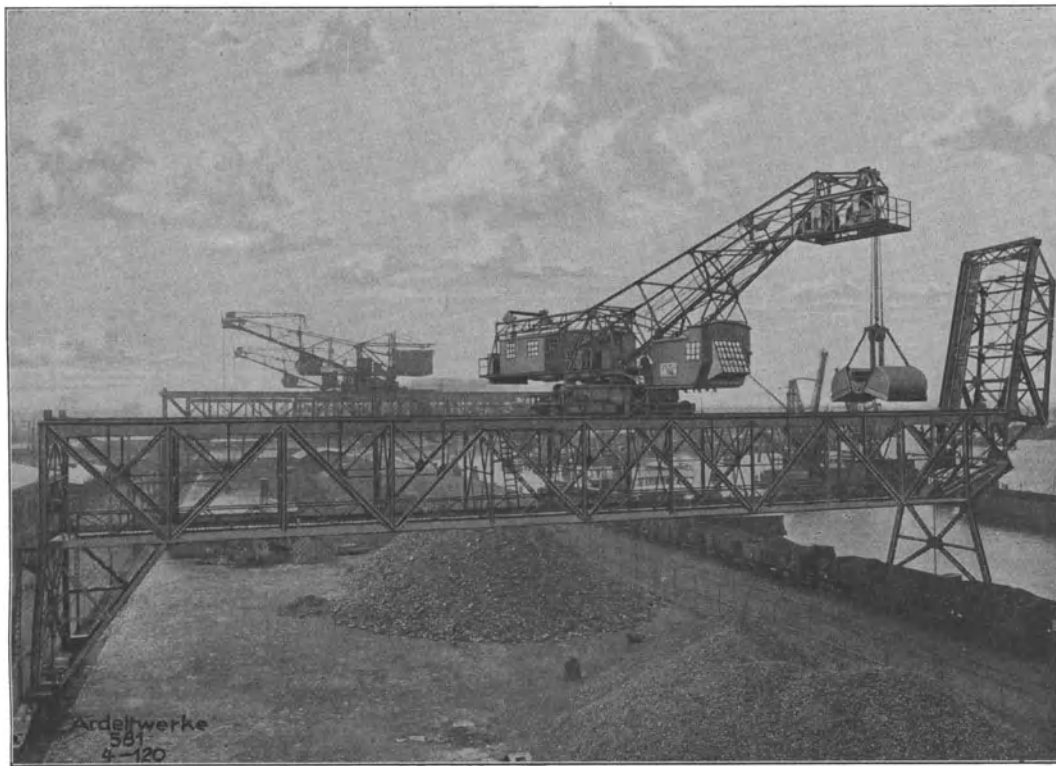
Abb. 6. Elektrisch betriebene Verladebrücken mit Drehkränen.
