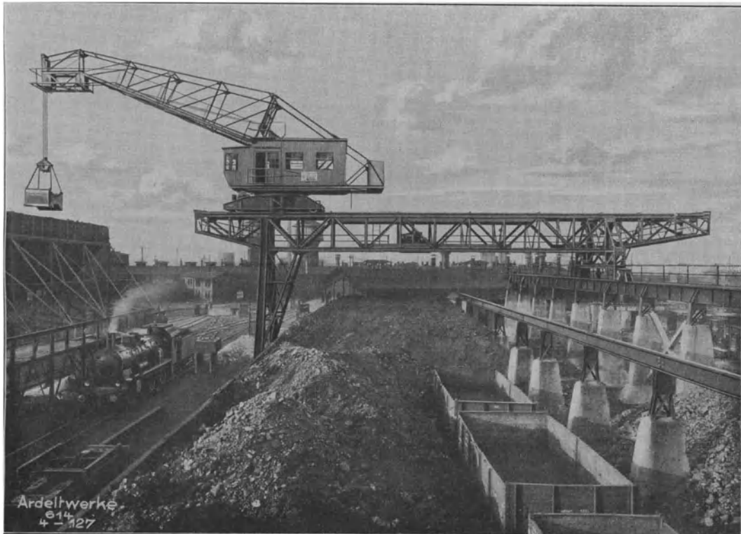
Abb. 14. Bekohlungsanlage: Verladebrücke mit Drehkran.
