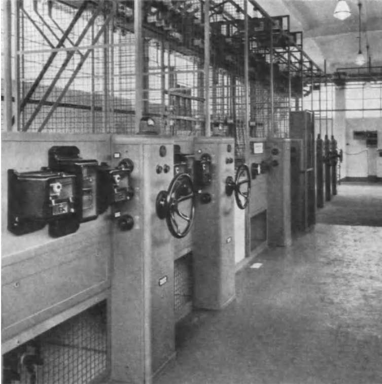
Abb. 1. Relais im Bedienungsgang.
