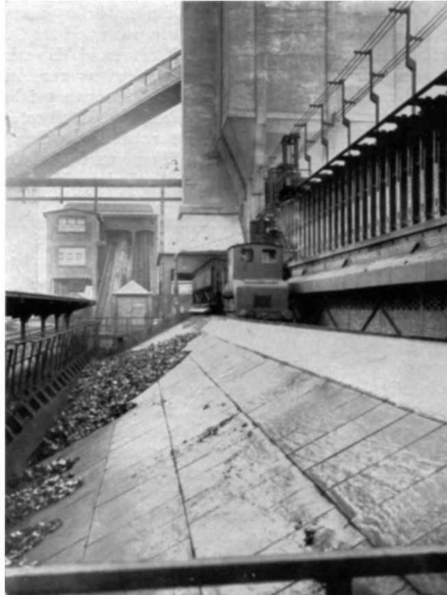
Bild 184. Abwurframpe, Koks-löschwagen und Förderband einer Kokereianlage.
