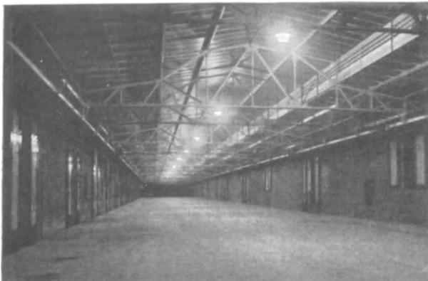
Abb. 338. Verbindungshallenbeleuchtung mit Leuchten für direktes Licht (Kandem).
