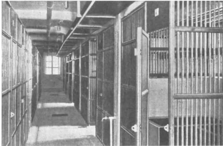
Abb. 212. Pökelfraum. Zellen aus imprägniertem Hartholz (Beck & Henkel).
