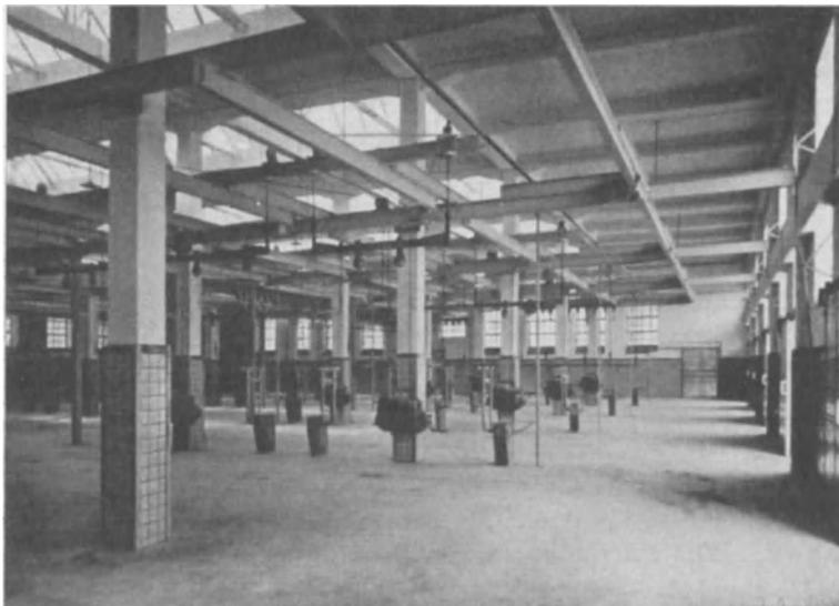
Abb. 31. Großviehhalle Bochum mit säulenständigen Winden und quergelegten Spreizen (Oberlicht).
