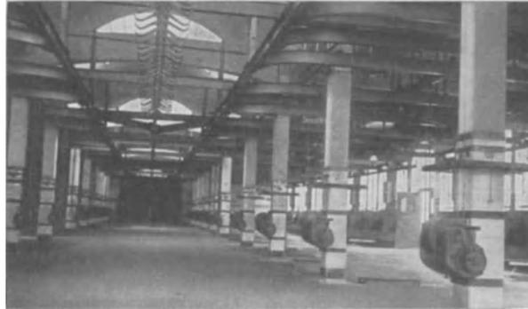
Abb. 32. Großviehslachthalle mit säulenständigen Winden.
