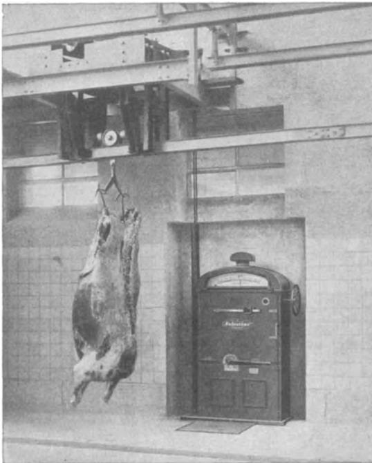
Abb. 40. Hängebahnwaage (Schmidt & Co., Düsseldorf).
