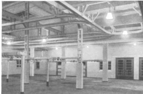
Abb. 337. Vorbildliche Schlachthallenbeleuchtung durch vorwiegend tiefstrahlendes Licht. Abgedichtete Kandem-Leuchten (Seegrenzschlachthof Hamburg).
