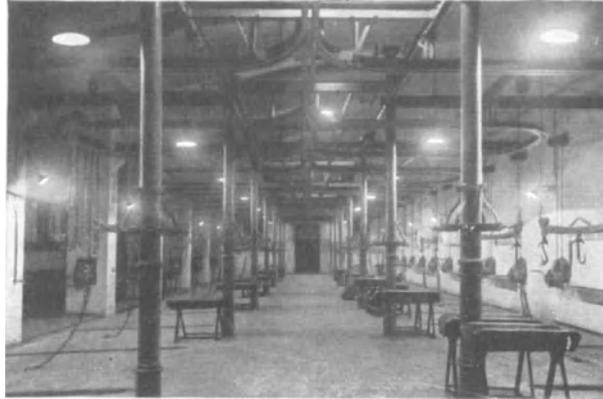
Abb. 336. Schlachthallenbeleuchtung durch Tiefstrahler in Höhe der Laufschiene angeordnet. Zusätzliche Beleuchtung durch seitliche Leuchten an Wandarmen (Kandem, Leipzig).
