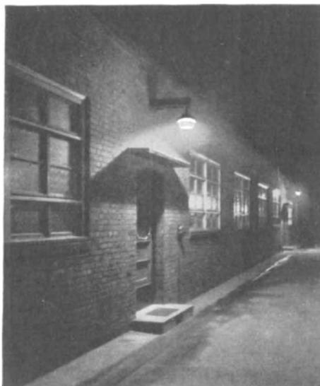
Abb. 339. Außenbeleuchtung der Schlachthofstraße. Profileisenausleger mit Kandem-Off-Leuchten über den Eingängen.
