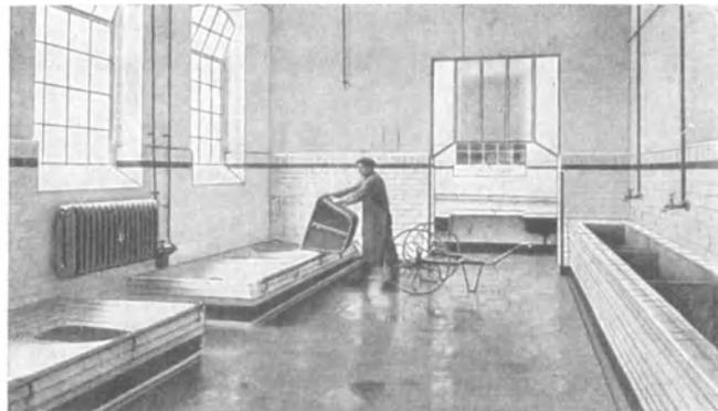
Abb. 174. Betontische zur Magenentleerung und langgestreckte Waschtische (Beck & Henkel).
