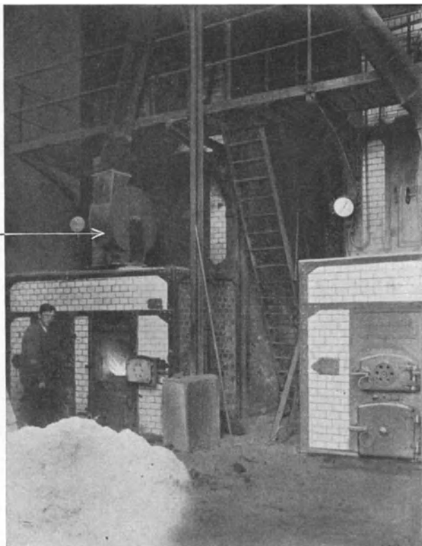
Abb. 42. Schebenfeuerung und Hefterscher Schebentrocknungsapparat (a).
