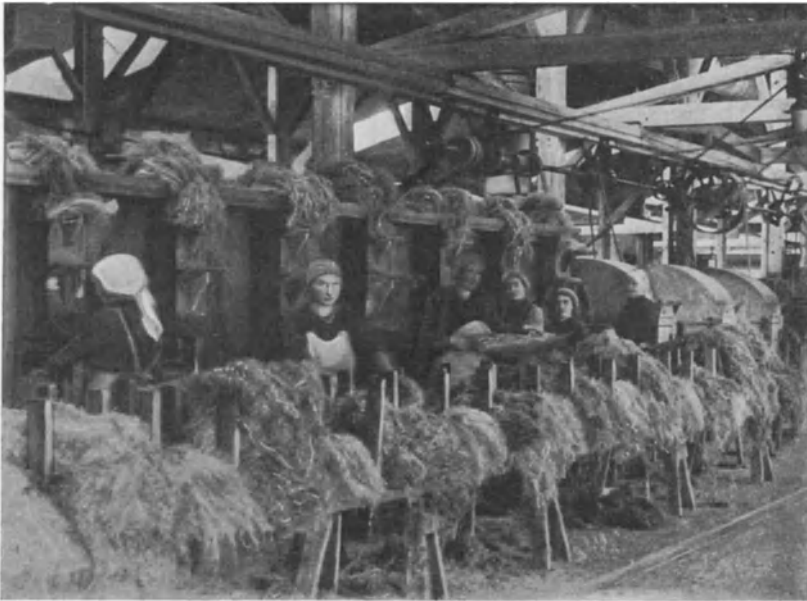
Abb. 33. Schwingstände, links belgische, rechts Haase-Systeme.
