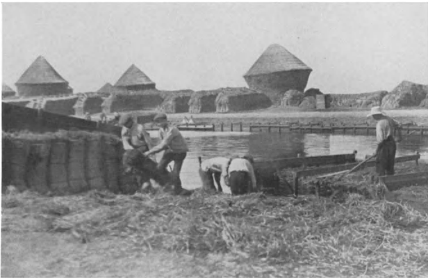
Abb. 16. Lysröste bei Harlebeke. Entleeren eines Röstkastens.
