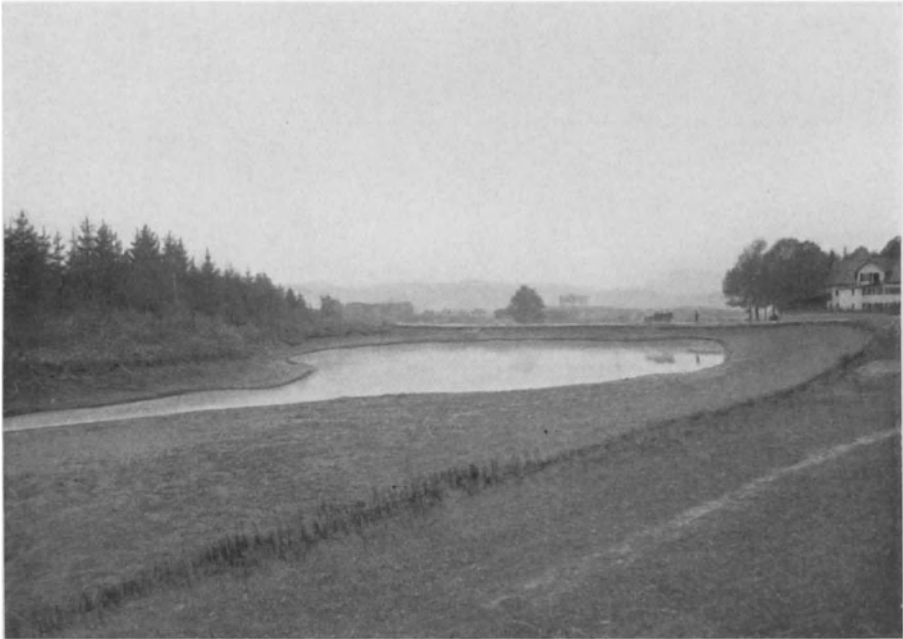
Abb. 8. Kaltwasserröste. Der Teich ist nach der Röste zur Hälfte abgelassen worden, links das natürliche Becken zum Vorwärmen des Wassers.
