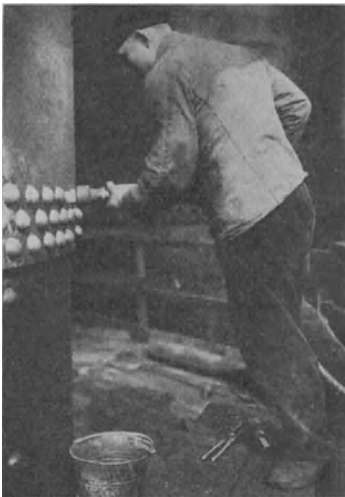
Abb. 9. Nieten mit Preßlufthammer (A. Borsig, Berlin).
