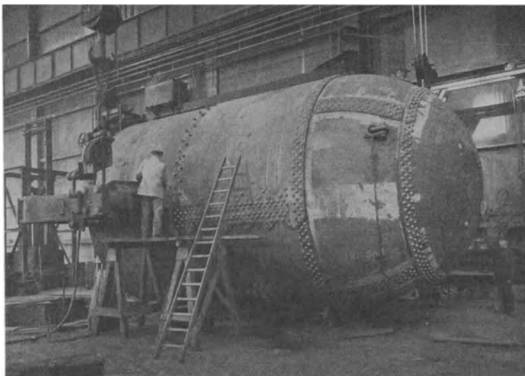
Abb. 10. Nieten mit beweglicher Nietmaschine (Ruthsspeicherbau).
