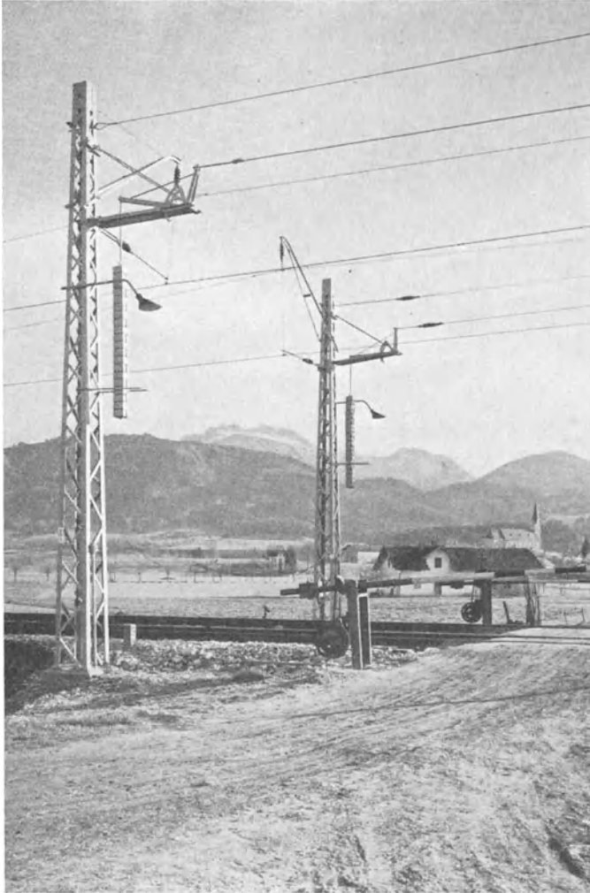
Abb. 245b. Kettenfahrleitung mit Gewichtsnachspannung durch Hebel (SSW).
