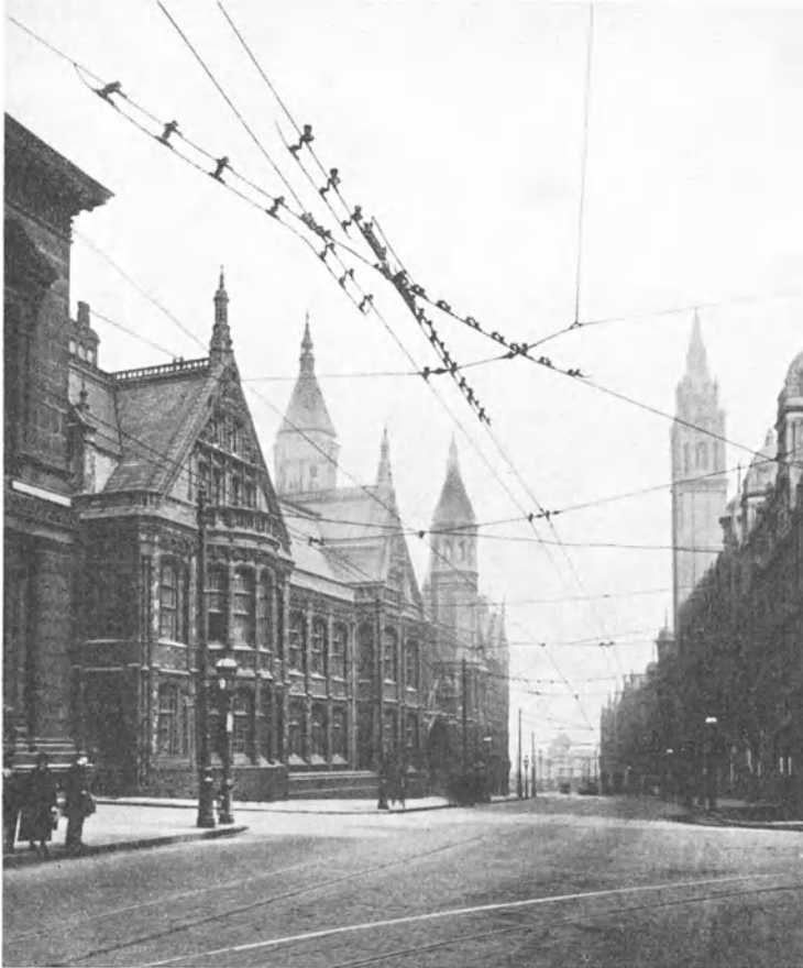
Abb. 222. Fahrleitung für Oberleitungsomnibusse.
