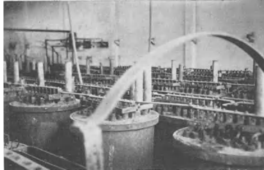
Abb. 90. Chloratanlage (Legnano, Italien).
