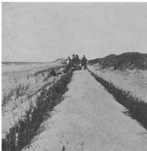
Abb. 209. Schaffung einer Vordüne an der Küste der Kurischen Nehrung. Der Raum zwischen den beiden Flechtzäunen ist schon fast zugeweht. Links von der Vordüne (meeresseitig) Reihenpflanzung von Strandgräsern, im Hintergrund rechts befestigte alte Wanderdüne. (Aufn. von Dengler.)
