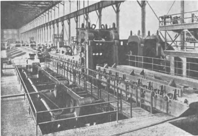
Abb. 47. Triogerüst der Schienenstraße der Illinois Steel Co., Gary.
