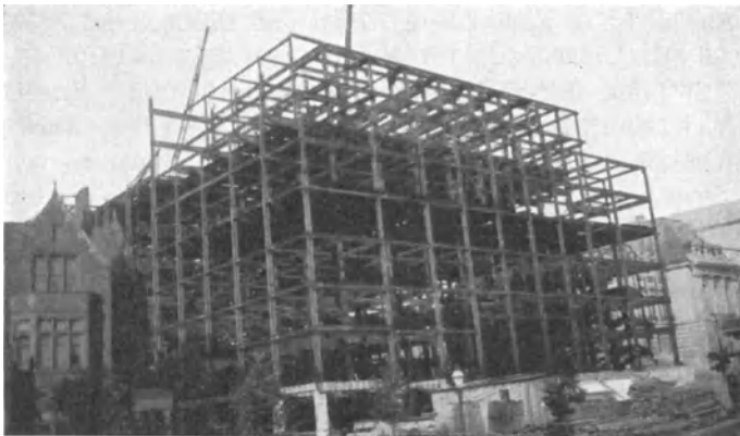
Abb. 66. St. Louis, Hochhaus im Bau.
