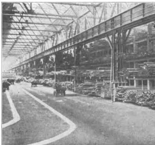
Abb. 75. Safety-Linien im Rohrlageraum der National Tube Co., Ellwood.
