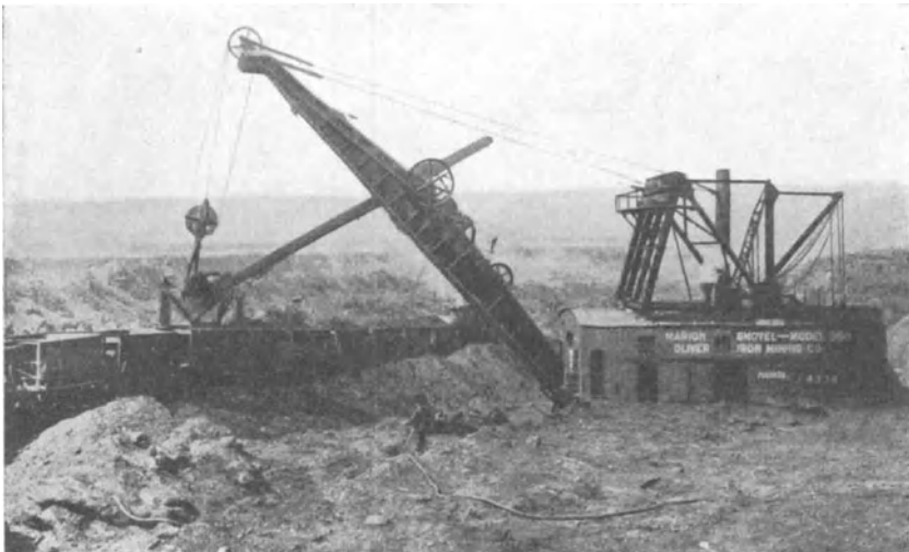
Abb. 8. Dampfschaufel in einem Erztagebau des Seengebietes.
