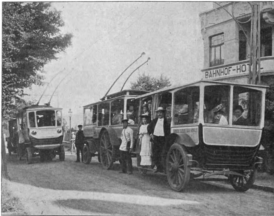
Abb. 24. Betrieb der gleislosen elektrischen Bahn von Neuenahr nach Walporzheim.
