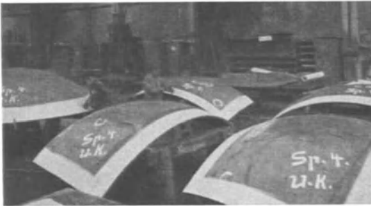
Abb. 13b. Anrichten der Teile für die Kugelböden.
