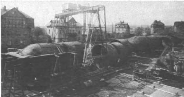
Abb. 14. Zusammenbau der Speicherbehälter am Aufstellungsort (Ruths-Gefällespeicher von 300 m 3 ).
