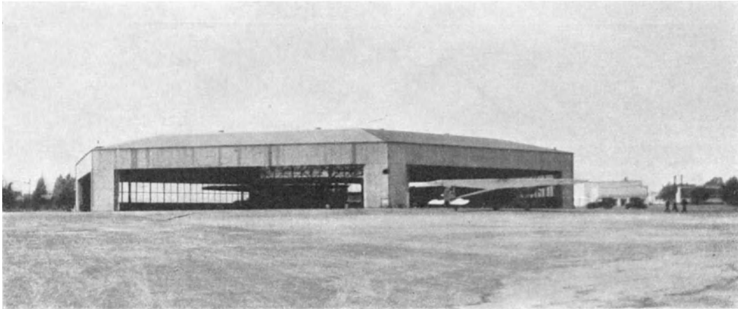
Abb. 41. Hexagonhalle auf dem Flughafen Alhambra bei Los Angeles (Cal.).
