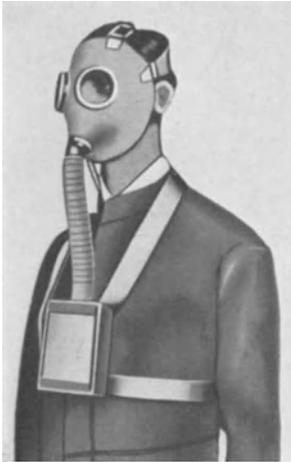
Abb. 61. Ein Apparat nach HOPCALITE. Die Maske hat eine expiratorische Klappe unter dem Kinn.
