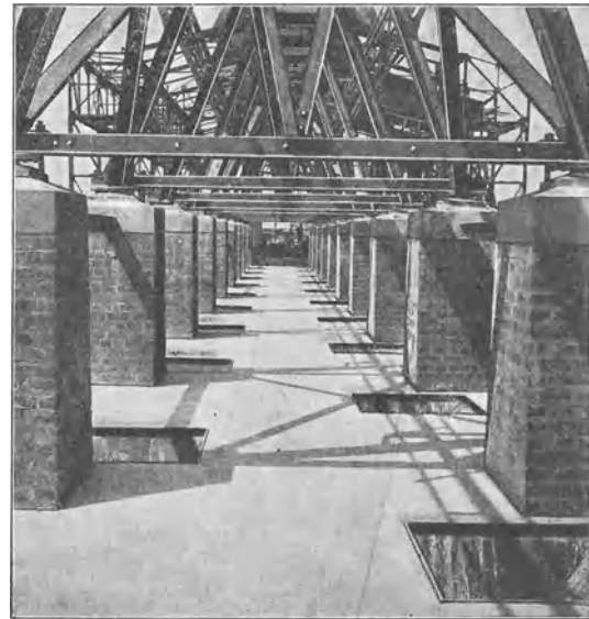
Abb. 167. Kraftwerk Vereeniging. Kohlenlager unterhalb der Kohlenbahn, auf dem Boden Einfalltrichter für die Becherkette.
