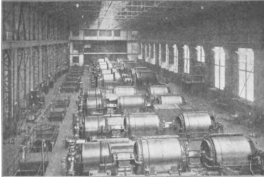
Abb. 137. Kraftwerk Roshervilledam. Ansicht des fertigen ersten Ausbaues: 5 Generatoren, 4 Kompressoren.
