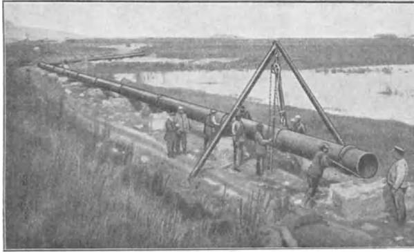
Abb. 154. Druckluftanlage. Verlegung eines 24 zölligen Rohres oberhalb des Erdbodens auf gemauerten Pfeilern (sumpfiger Untergrund).
