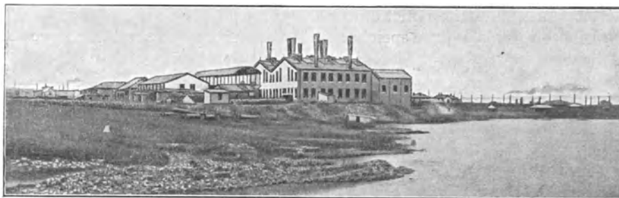
Abb. 107. Kraftwerk Simmerpan. Ansicht. Im Vordergrund Wirtschaftsgebäude; vor den Kesselhäusern der Kohlenbunker.
