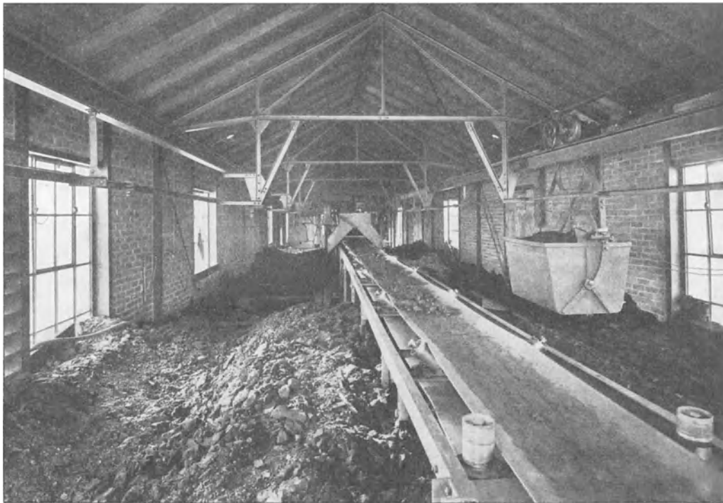
Abb. 18. Kohlenbunker im E. W. Hirschfelde. Seilbahn und Gurtförderer über dem Kohlenbunker.
