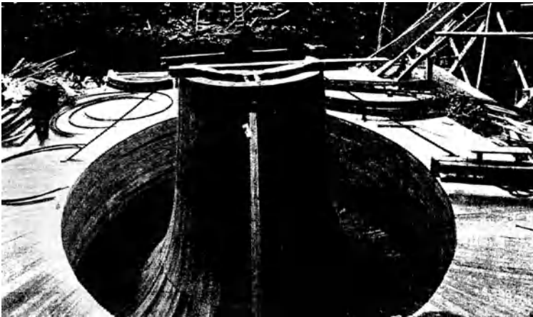
Abb. 39. Niagara-Kraftwerk (U. S. A.). Schalung der Saugrohrglocke und Saugkammerdecke. (Engg. News Rec. Bd. 85, Nr. 13.)
