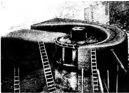
Abb. 40b. Schalung der Einlaufspirale.
