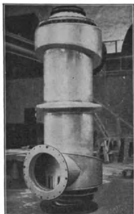
Luftvorwärmer 45 qm Fläche aus V2A-E-Stahl
