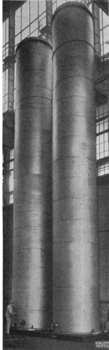
Zwei Türme aus V2A-Blech 16 500 mm Höhe 2 250 mm \varnothing
