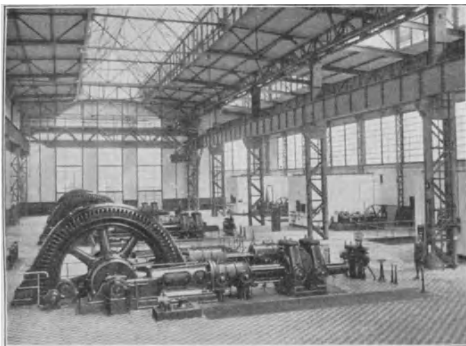
Fig. 9. Drei Einheiten für die Wasserstoffherzeugung nach Claude (Tagesleistung 3ma 170000 cbm Kokereigas) in Rauxel.
