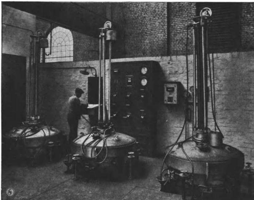
Abb. 227. Blankglühofen (SSW, Heraeus-Rohn, Stassinnet). Der mächtige Aufbau über den Ofendeckeln ist die — während des Heizens ausgefahrne — Kühlvorrichtung. — Hinter den Öfen die Schaltanlage in einem Schaltschrank untergebracht. — Vorne links an jedem Ofen die Wasserkühlung für die Deckeldichtung.
