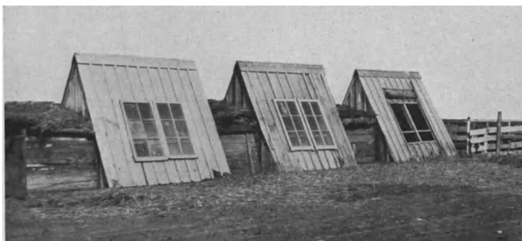
Abb. 209. Versuchsställe für Schweine zur Prüfung der Lichtwirkung. Rechts offenes Fenster, in der Mitte gewöhnliches Fensterglas, links Vitaglas. (Nach SHAW 289 .)
