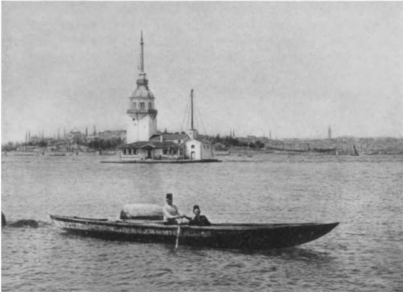
Einfahrt beim Leander-Turm
