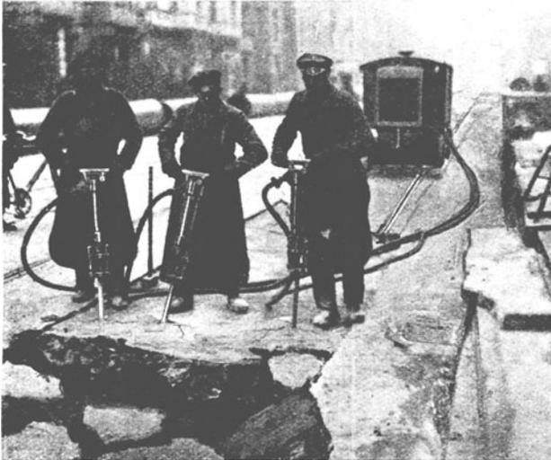
Abb. 11. Aufbrechen einer Betonstraße
