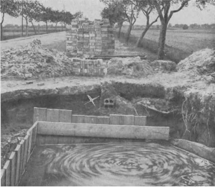
Abb. 12. Schachtarbeiten beim Brunnenbau.
