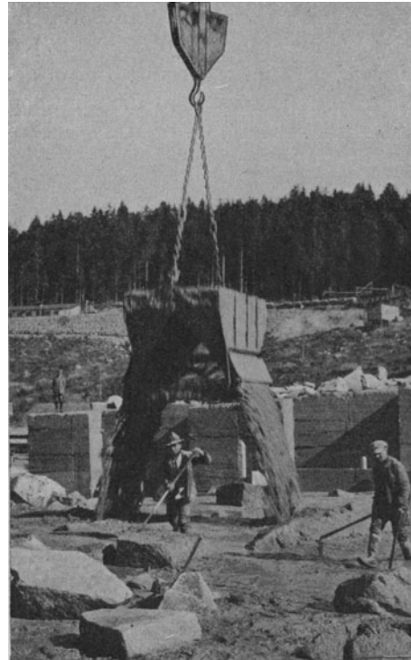
Abb. 126. Entleerung eines Betonkübels beim Bau der Schwarzenbachsperre. (Siemens-Bau-Union.)
