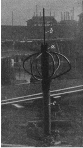
Abb. 469. a Handramme, b Führungsnadel, c Pfahl.
