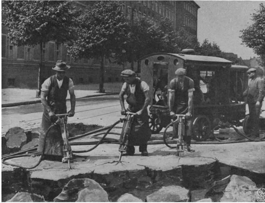
Abb. 220. Aufreißhammer. (Flottmann A.-G., Herne.)
