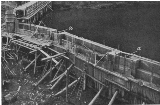
Abb. 294. Füllöffnungen (a) im Betonfangdamm beim Bau des Murwehres in Mixnitz.
