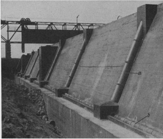
Abb. 107. Rückansicht einer Betonufermauer im oberen Vorhafen des Schiffshebwerkes Niederfinow vor dem Hinterfüllen. (Neubauamt Eberswalde.)
