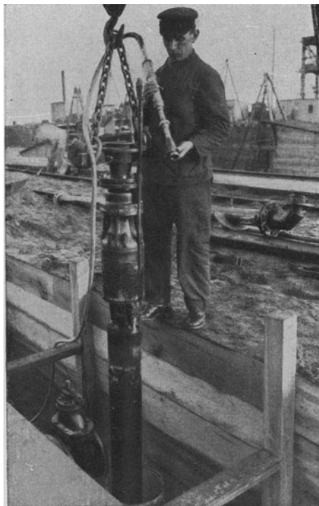
Abb. 361. Ansicht der Siemens-Elmo-Tauchpumpe „Motor unten“. (Nach Sichardt: Bautechnik 1929 S. 406.)
