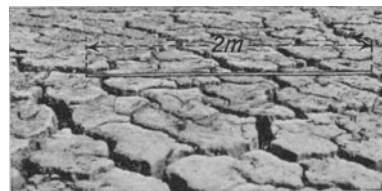
Abb. 6. Schwindrisse in den Schlammablagerungen des Langmann-Stauweihers der Teigtischwerke.
