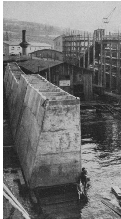
Abb. 428. Eisenbetonschwimmkästen am Helling in Fiume. (Dyckerhoff & Widmann.)
