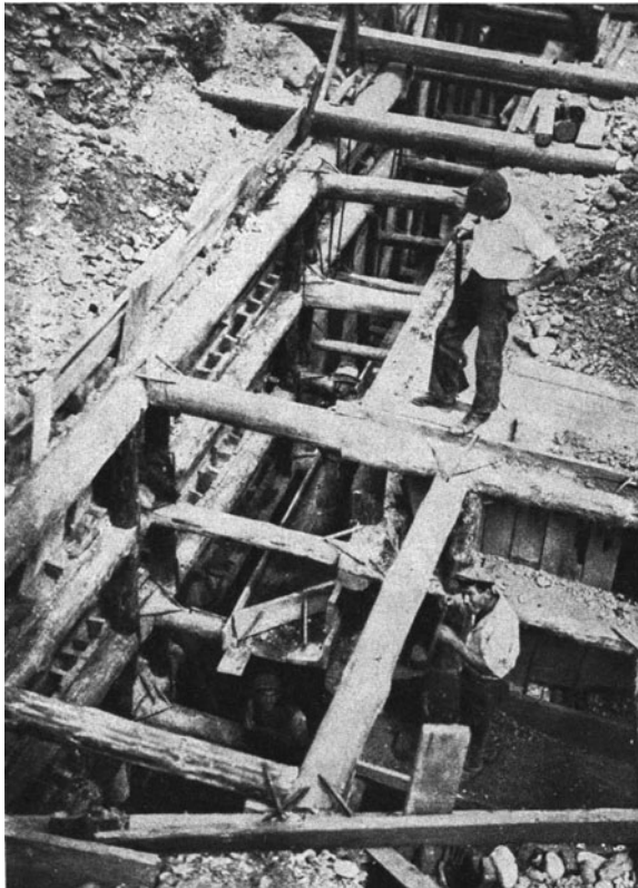
Abb. 264. Lotrechte Zimmerung im Schlitz für die Herdmauer des Krafthauses Pernegg a. d. Mur. (Aus A. Schoklitsch: Der Wasserbau. Berlin: Julius Springer.)
