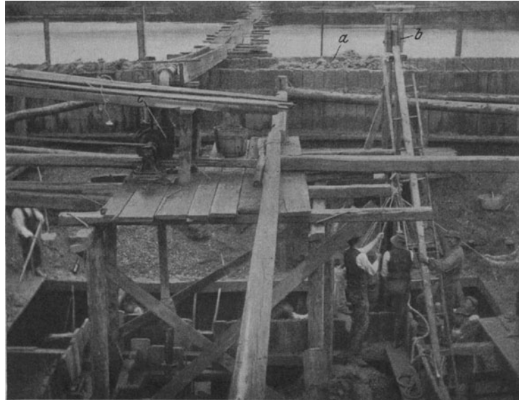
Abb. 306. Einfacher Kastenfangdamm für die Gründung eines Brückenwiderlagers an der March bei Certorei.
