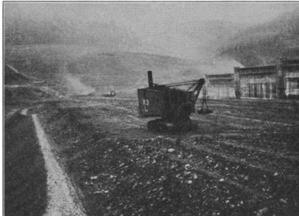
Abb. 374. Verdichtung des Bodens durch Stampfen. (Menck & Hambrock, Altona.)
