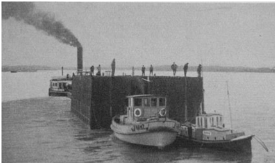
Abb. 650. Schwimmende Beförderung eines Druckkastens für einen Pfeiler der Donaubrücke in Páncsova. (Dyckerhoff & Widmann.)
