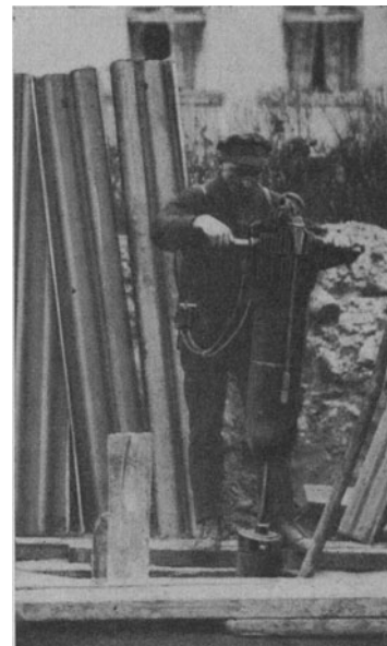
Abb. 175. Rammen von Pfählen und Union-Kanal-dielen mittels einer Demag-Explosionsrahmen. (Vereinigte Stahlwerke A.-G. Dortmunder Union.)
