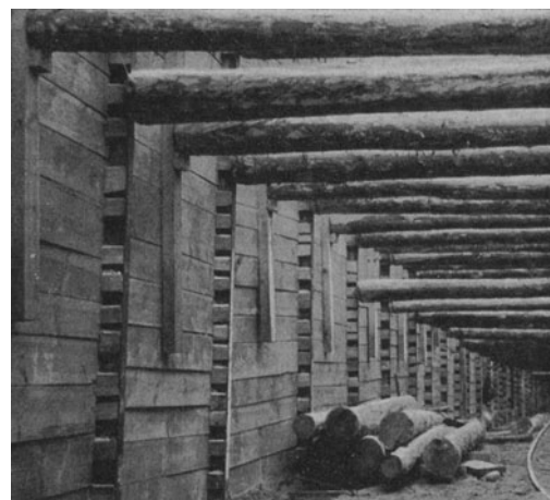
Abb. 257. Absteifung einer Wand mit waagrechten Bohlen zwischen geramnten I-Trägern. Vgl. Abb. 256c. (Siemens-Bau-Union.)
