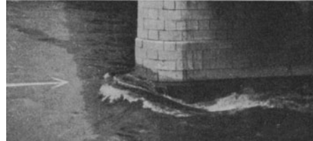
Abb. 111. Kopfwelle an einem Brückenpfeiler (S. Shulits).
