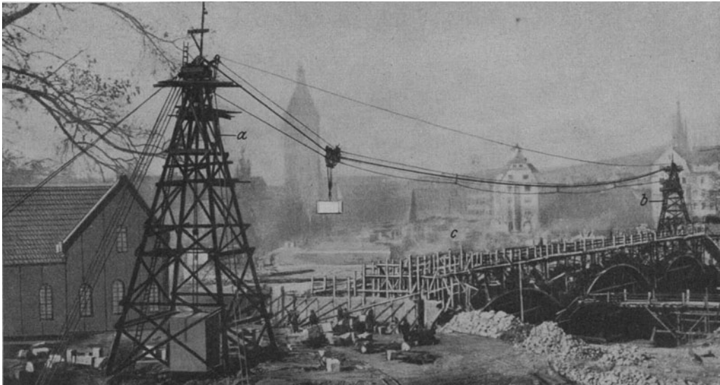
Abb. 247. Fahrbarer Kabelkran bei einem Brückenbau. (Vgl. Abb. 244.) (A. Bleichert & Co.) a Ortsfester, b fahrbarer Turm, c Lagerplatz.
