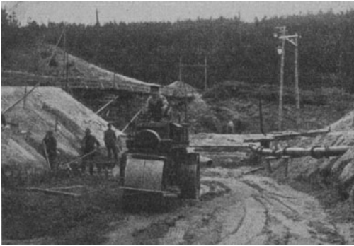
Abb. 373. Verdichtung des Bodens durch Walzen. (Siemens-Bau-Union.)
