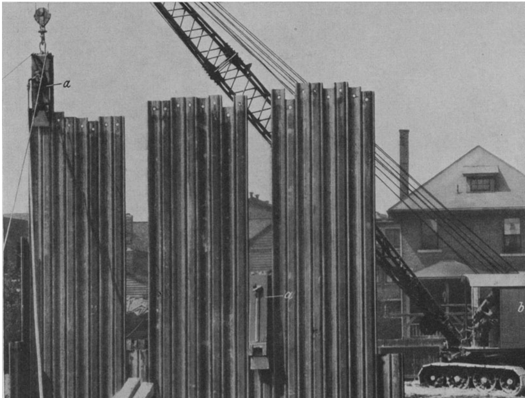
Abb. 168. Rammen einer eisernen Lackawanna-Spundwand mittels Mc Kiernan-Terry-Pfahlhämtern a . b Kran auf Raupenband. (Mc Kiernan Terry Corp., New York.)
