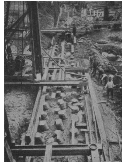
Abb. 529. Tiefliegender Holzpfahlrost für eine Ufermauer.
