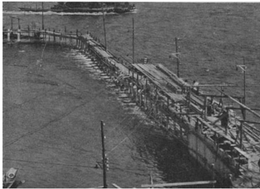
Abb. 319. Herstellung des Betonfangdammes beim Bau des Rheinkraftwerkes Ryburg-Schwörstadt. (Motor-Columbus, Baden.)
