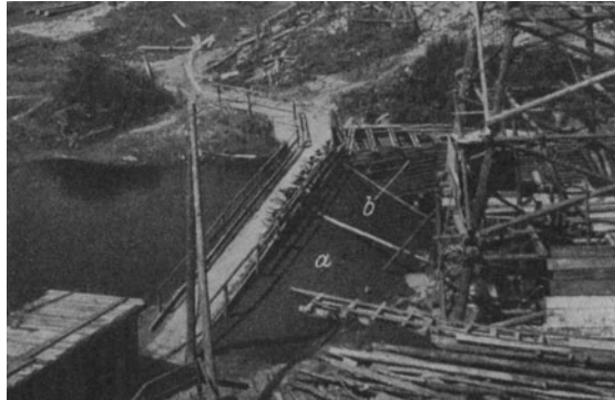
Abb. 297. Fangdamm (a) beim Bau der Packsperr der Teigitschwerke. (b) Umlaufgerinne. (Steweag, Graz.)
