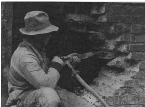
Abb. 234. Druckluftpickhammer beim Abtragen von Mauerwerk. (Flottmann A.-G., Herne.)
