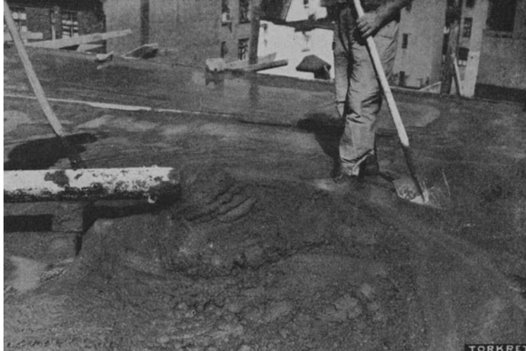
Abb. 128. Mit der Betonförderpumpe geförderter Beton fließt aus dem Rohr. (Torkret-Gesellschaft.)
