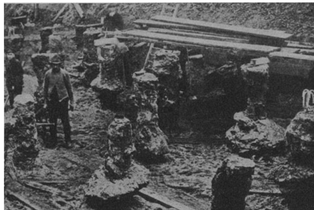
Abb. 502. Freigelegte Köpfe von Wolfsholz-Preßbetonpfählen. (A. Wolfsholz.)
