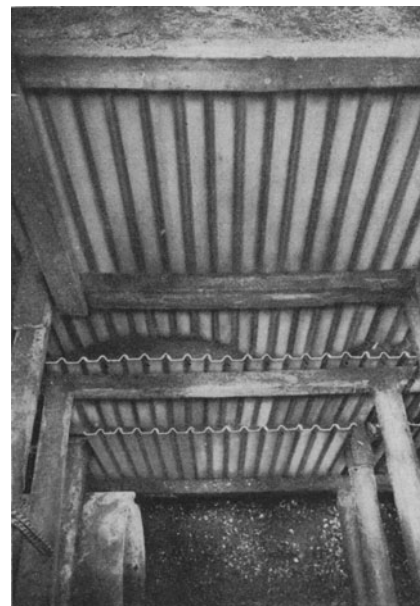
Abb. 272. Baugrubenaussteifungen mit Union-Kanaldielen. (Vereinigte Stahlwerke A.-G. Dortmunder Union.)
