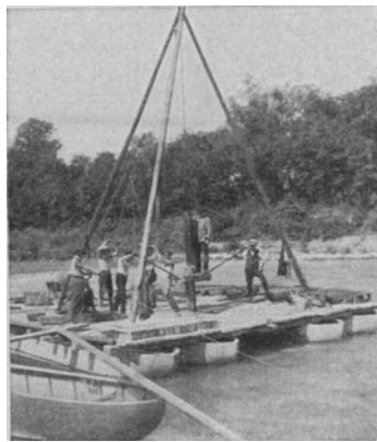
Abb. 20. Erkundung der Bodenbeschaffenheit durch Bohrung von Schiffen aus für das Isarwehr in Oberführung. (Mitt. Isar A.-G.)
