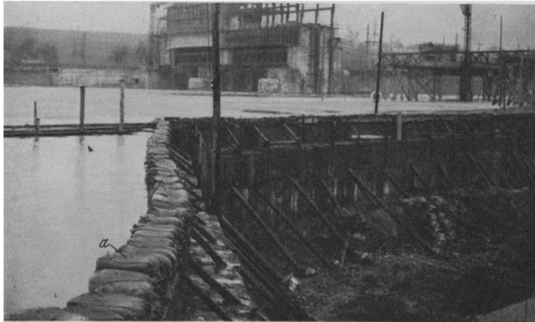
Abb. 318. Betonfangdamm beim Bau des Kachletwerkes in der Donau bei Passau. (Grün & Bilfinger.)
