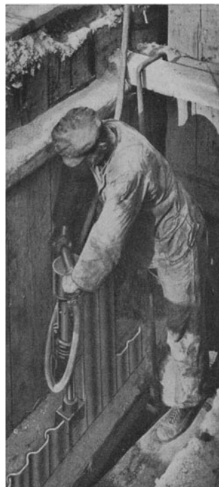
Abb. 174. Rammen von Union-Kanal-dielen mittels eines Klein-Pfahlhammers. (Vereinigte Stahlwerke A.-G. Dortmunder Union.)
