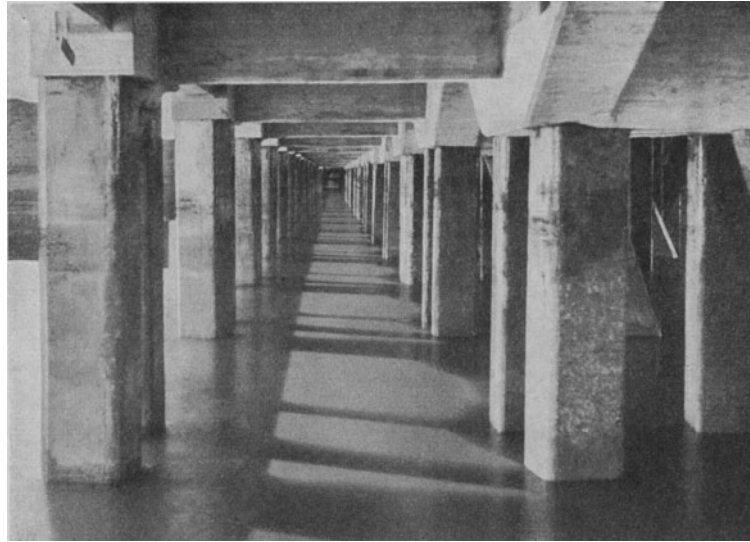
Abb. 560. Blick unter den hochliegenden Rost der Ufermauer in Charleston. (McKiernan Terry Corp., New York.)
