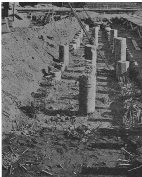
Abb. 541. Gerammte Schleuderbetonpfähle für eine Gebäudemauer. (Siemens-Bau-Union.)
