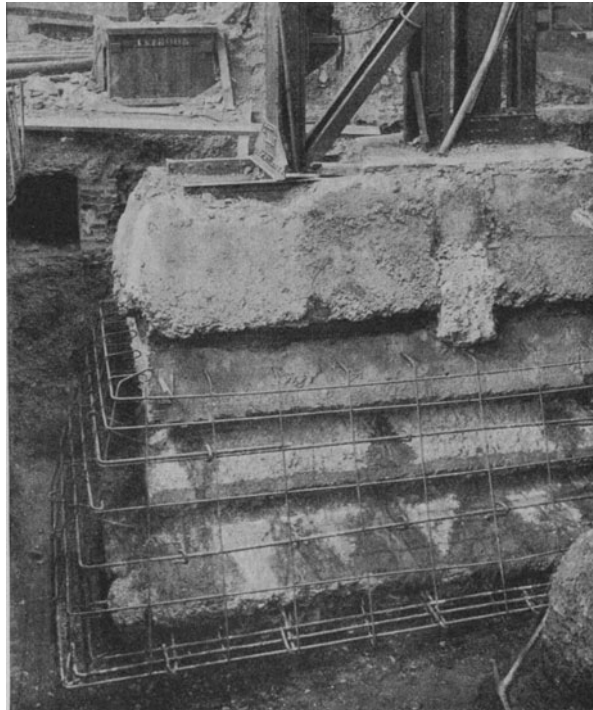
Abb. 714. Verstärkung eines Säulengrundwerkes. (Siemens-Bau-Union.)
