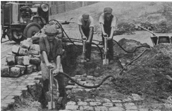
Abb. 219. Anwendung des Spatenhammers. (Flottmann A.-G., Herne.)
