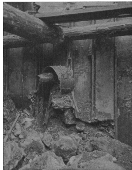
Abb. 158. Aufgerollte Larssen-Bohle. (Wayß und Freytag.)
