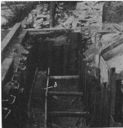
Abb. 240. Wurfbühne (b) in der Baugrube für ein Brückenwiderlager; (a) Larsen-Spundwand. (A. Spritzer A.-G. Wien.)
