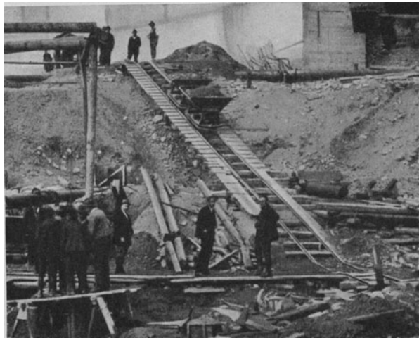
Abb. 241. Schrägaufzug für die Beförderung des Aushubes aus der Baugrube. (Siemens-Bau-Union.)
