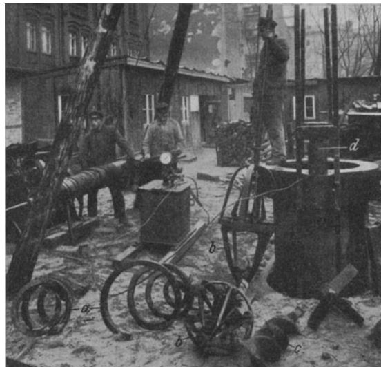
Abb. 17. 1200 mm weite Tiefbohrung. (H. Nilewsky-W. Noçon, Charlottenburg.)
