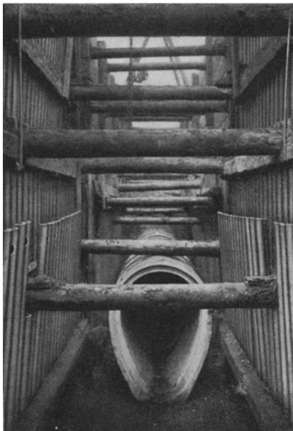
Abb. 272. Baugrubenaussteifungen mit Union-Kanaldielen. (Vereinigte Stahlwerke A.-G. Dortmunder Union.)
