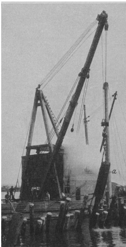
Abb. 487. Ein Mc Kiernan-Terry-Pfahlhammer (a) beim Rammen von Schrägpfählen. (Mc Kiernan Terry Corp., New York.)
