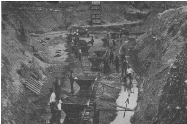
Abb. 336. Zuleitung des zugesickerten Grundwassers zum Pumpensumpf in einem offenen Graben beim Bau des Maschinenhauses des Murkraftwerkes Mixnitz.
