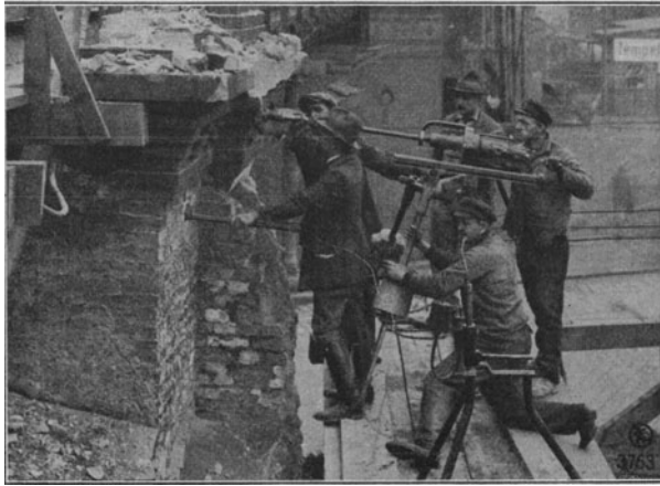
Abb. 238. Die Sprengpumpe von Tübben-Linnemann. (Flottmann A.-G. Herne.)
