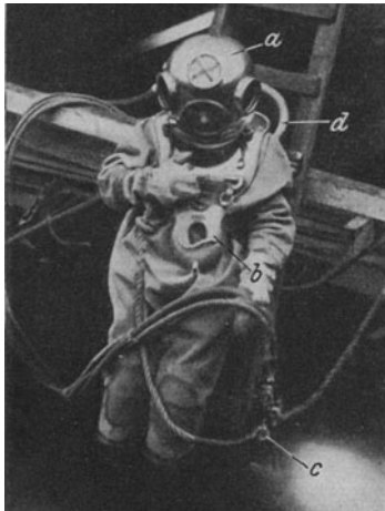
Abb. 703. Taucher. (Siemens-Bau-Union.) a Helm, b Brustblei, c Unterwasserschneidbrenner, d Luftschlauch.
