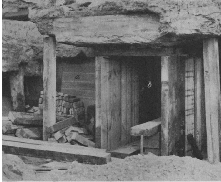
Abb. 275. Unterfangung eines neugeschossigen Gebäudes. (Siemens-Bau-Union.)
