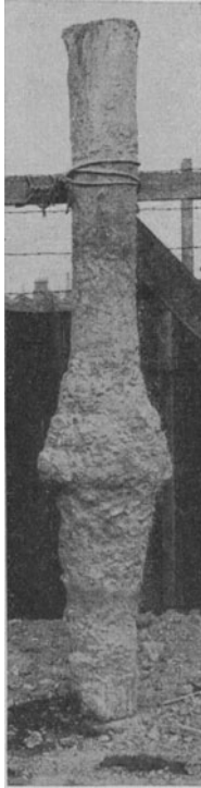
Abb. 497. Ausgegrabener Strauß-Pfahl. (Dyckerhoff & Widmann.)
