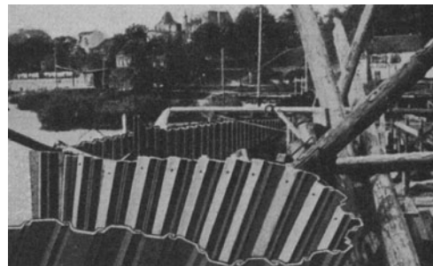
Abb. 321. Eingedrückte, aber dicht gebliebene Larssen-Spundwand. (Vereinigte Stahlwerke A.-G. Dortmunder Union.)
