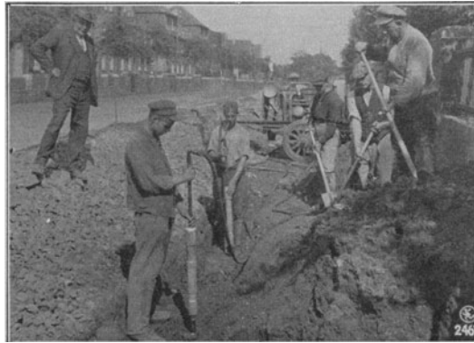
Abb. 281. Preßluftstamper. (Flottmann A.-G., Herne.)
