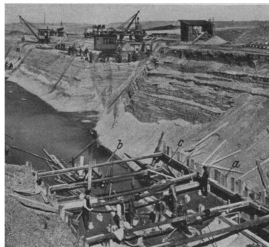
Abb. 266. Aussteifung der Baugrube für die Abwasserreinigungsanlage Dresden-Kaditz. (Dyckerhoff & Widmann.)
