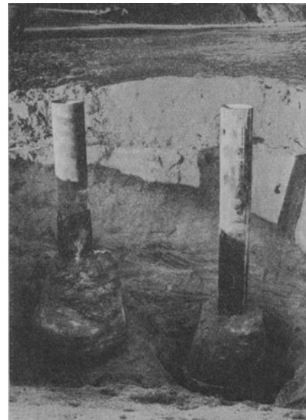
Abb. 495. Ausgegrabene Aba-Lorenz-Pfähle.
