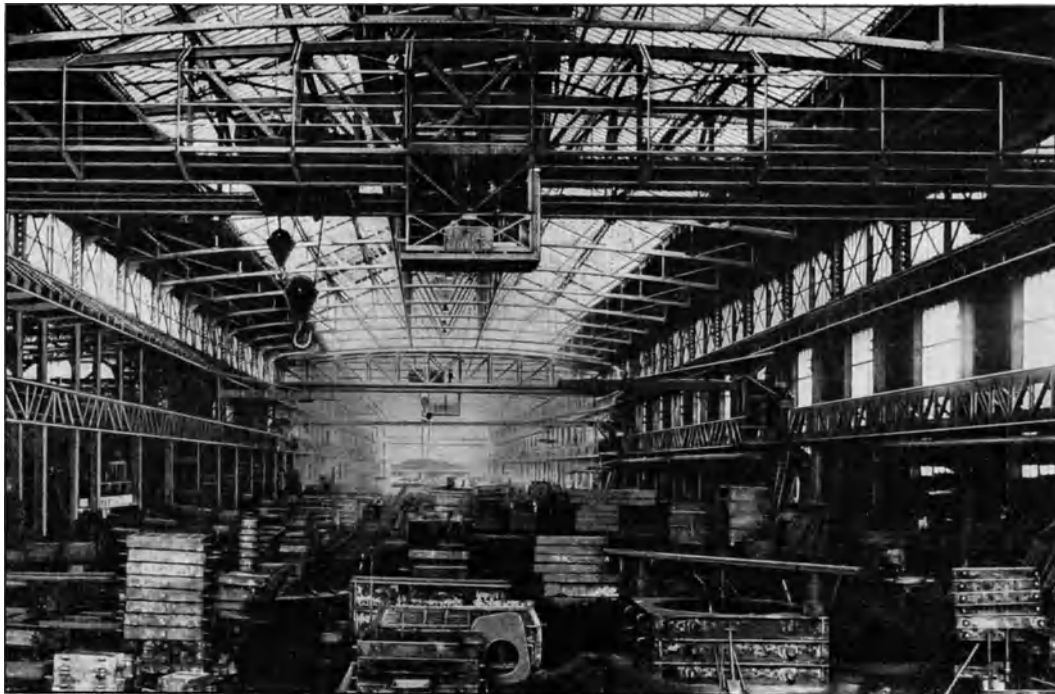
Abb. 149. Gußwerk der Soc. Française de Constructions Mécaniques in Denain, Blick durch die große Halle.
