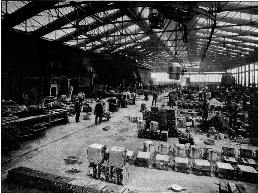
Abb. 143. Größerer Einhallenbau, Blick in die Gießhalle.
