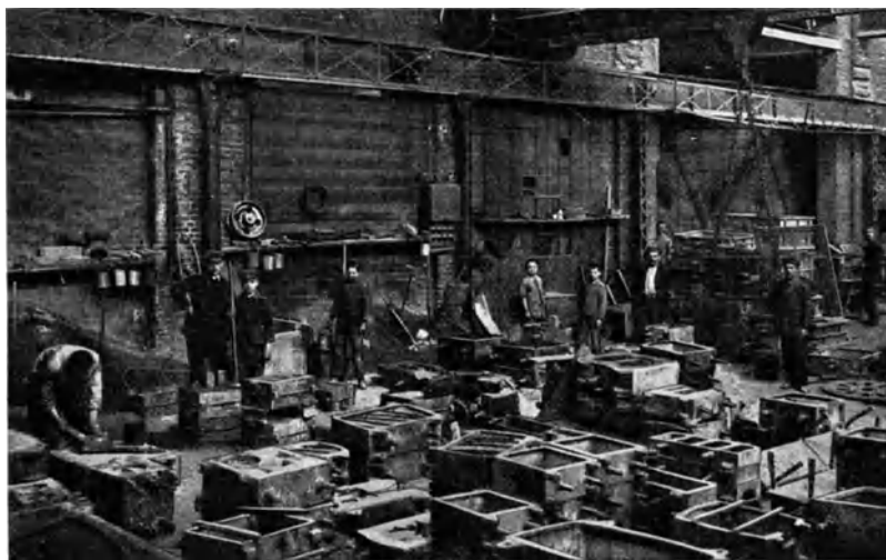
Abb. 506. Blick in die Lehrgießerei (Stahlguß) von Fried. Krupp, Grusonwerk, A.-G. in Magdeburg-Buckau.
