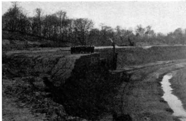
Abb. 461. Grube Osterfeld, Baggerbetrieb.
