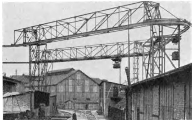
Abb. 105. Hängebahnanlage ohne Führer mit Steuerung durch Controller und Arbeit mit 2 Kübeln.
