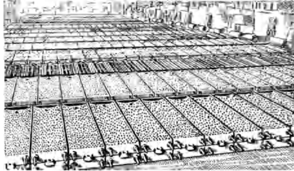
Abb. 293. Gurney - Gießerei, Blick in die mit Formen belegte Gießhalle.
