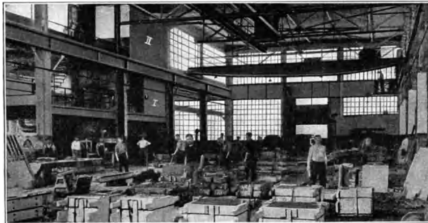
Abb. 204. New London Ship and Engine Co., Blick in die Gießhalle.
