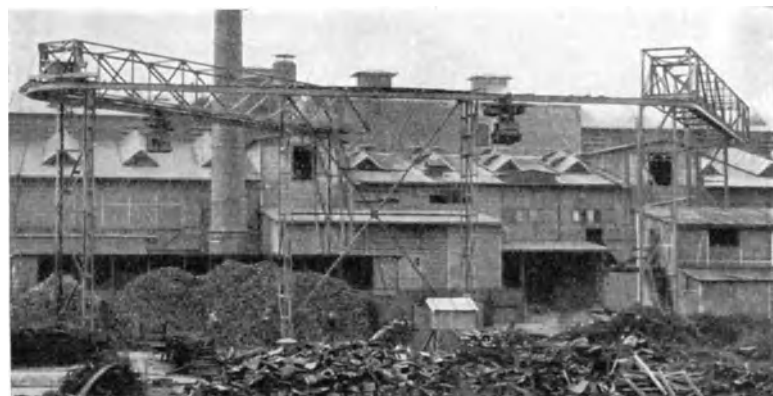
Abb. 106. Hängebahnanlage ohne Führer mit Steuerung durch Controller und Arbeit mit 2 Kübeln.
