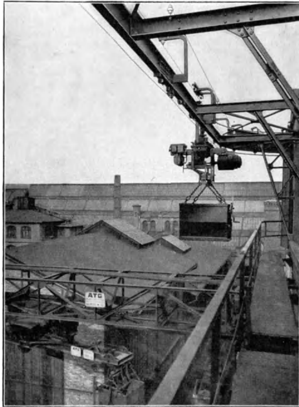
Abb. 114. Ferngesteuerter Hängebahnwagen, Teilansicht mit der elektrisch verfahrbaren Bühne.
