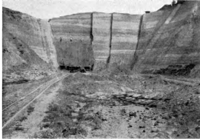
Abb. 460. Grube Ratingen, Stufenbau.
