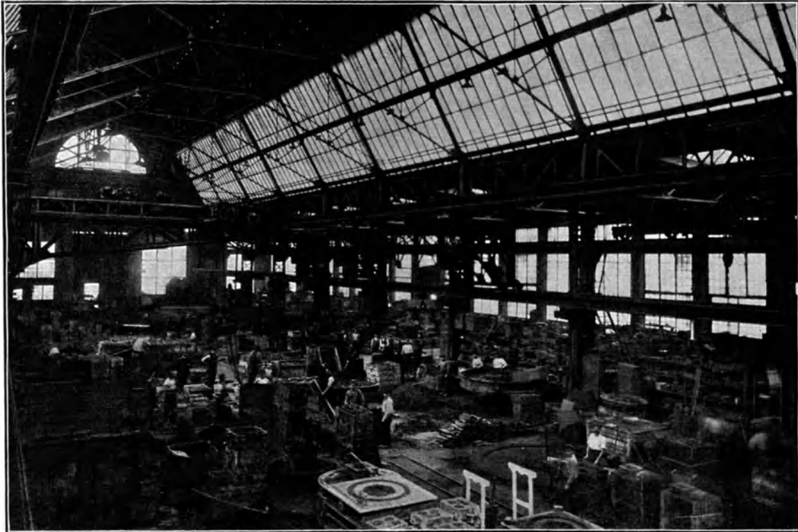
Abb. 277. Eisen- und Stahlgießerei Krautheim, Blick in den nordwestlichen Teil der Haupthalle.
