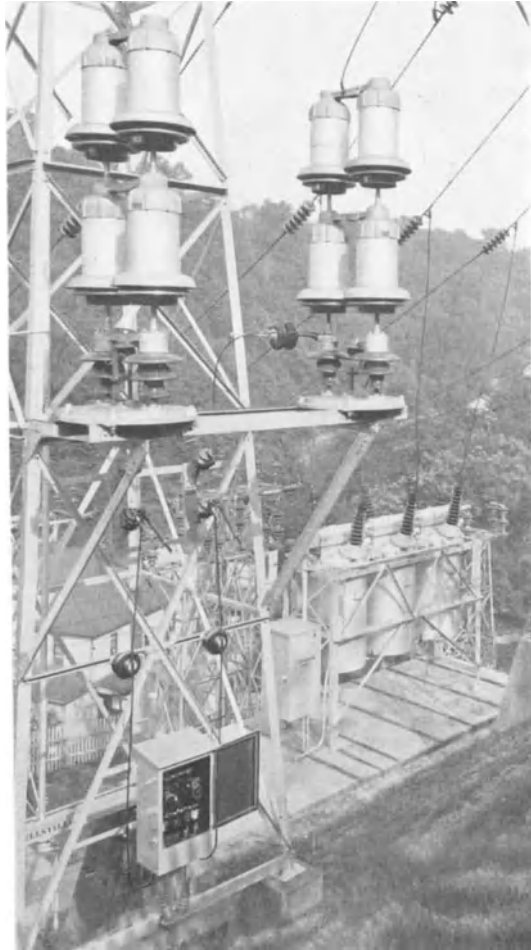
Bild 9. Ankopplung einer amerikanischen HF-Anlage mit Porzellankondensatoren.
