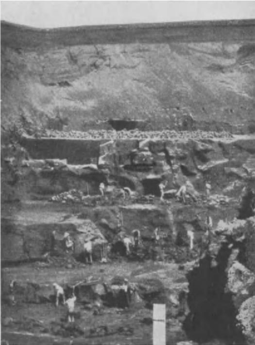
Abb. 44. Tuffsteingrube zur Gewinnung des Tuffs für die Traßherstellung (Herfeld-Andernach).
