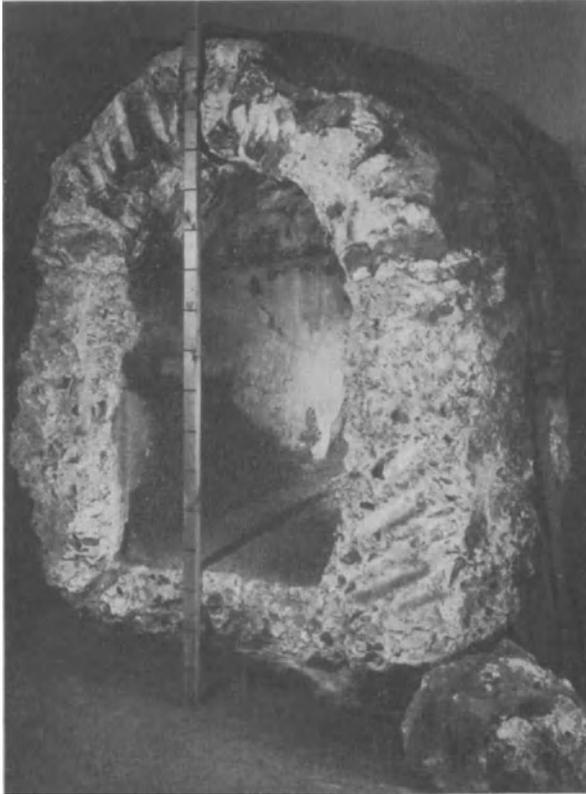
Abb. 8. Teilstück aus der 1.1 im Lichten hohen 90 km langen Wasserleitung, erbaut ca. 80 n. Chr. von der Eifel nach Köln aus Beton.
