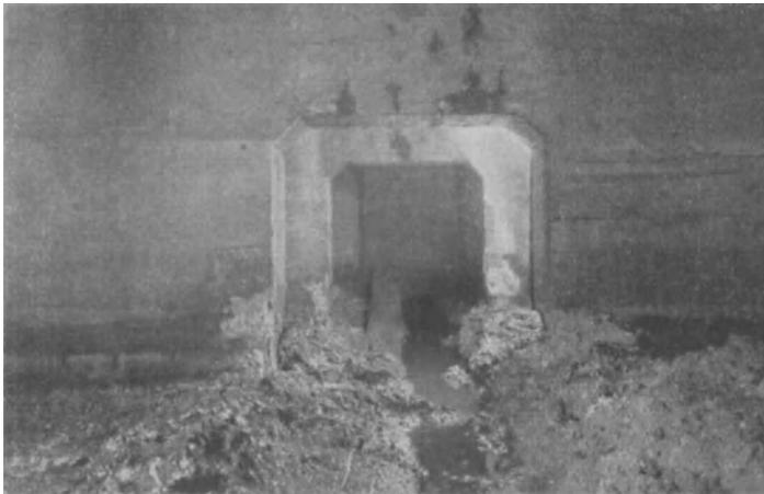
Abb. 78. Durch Sulfateinwirkung zerstörter Beton.
