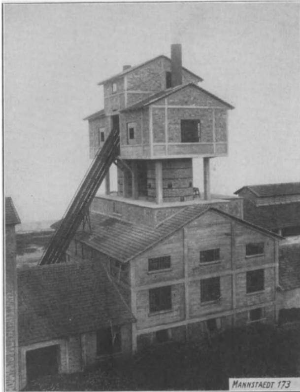
Abb. 16. Mannstädt, Schachtofen zum Brennen des Rohmehls zu Klinkern, Ansicht. (Klöknerwerke-Troisdorf.)
