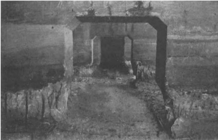
Abb. 79. Durch Sulfat zerstörter Beton nach Entfernung des zertriebenen Betons.
