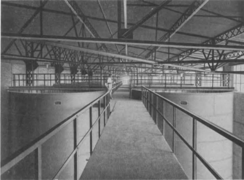
Abb. 15. Schlammbehälter zur Aufnahme und zum Mischen von gemahlenem Rohmehlschlamm
