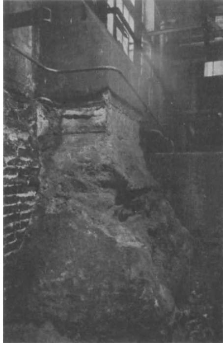
Abb. 77. Durch Ammoniumsalze zerstörter Beton.
