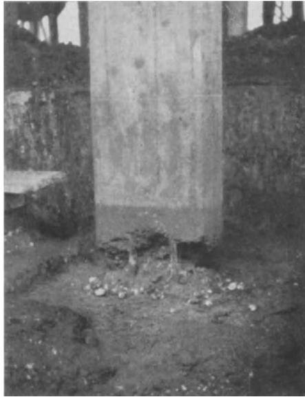
Abb. 74. Zerstörung von Betonsäulenfüßen durch frühzeitiges Überfluten mit schädlichem Wasser.
