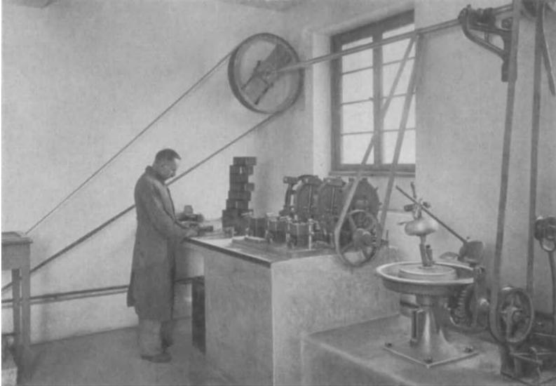
Abb. 56. Mischmaschine und Hammerapparat zur Zementnormenprüfung (Forschungsinstitut Düsseldorf).
