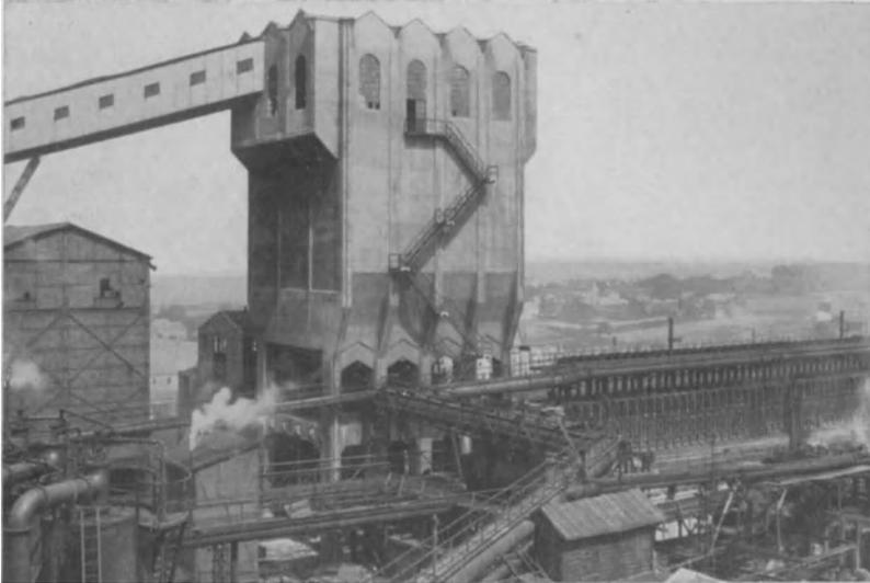
Abb. 85. Kohlenturm auf Zeche Nothberg des Eschweiler Bergwerks- und Hüttenvereins, errichtet aus Eisenportlandzement. (Wayss & Freytag, Düsseldorf.)
