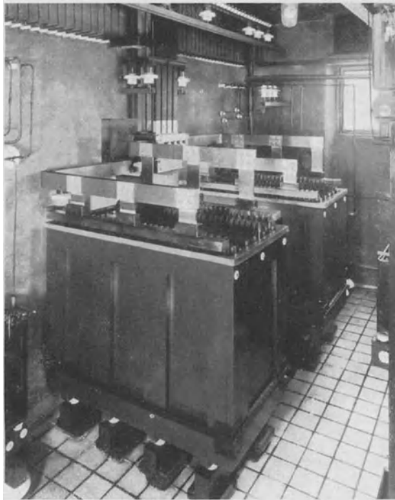
Abb. 6. Starkstrombatterie aus zwei großen Elementen.
