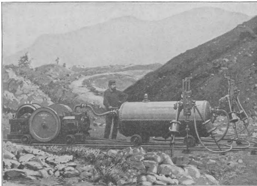
Fig. 185. Fahrbarer Kompressor von Meyer-Mülheim nebst fahrbarem Luftbehälter und Bohrmaschinen.
