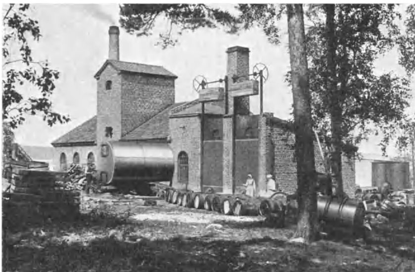
Abb. 62. Bewegliche Retorten für Nadelholzdestillation (Apparat-Aktiebolaget, Stockholm).
