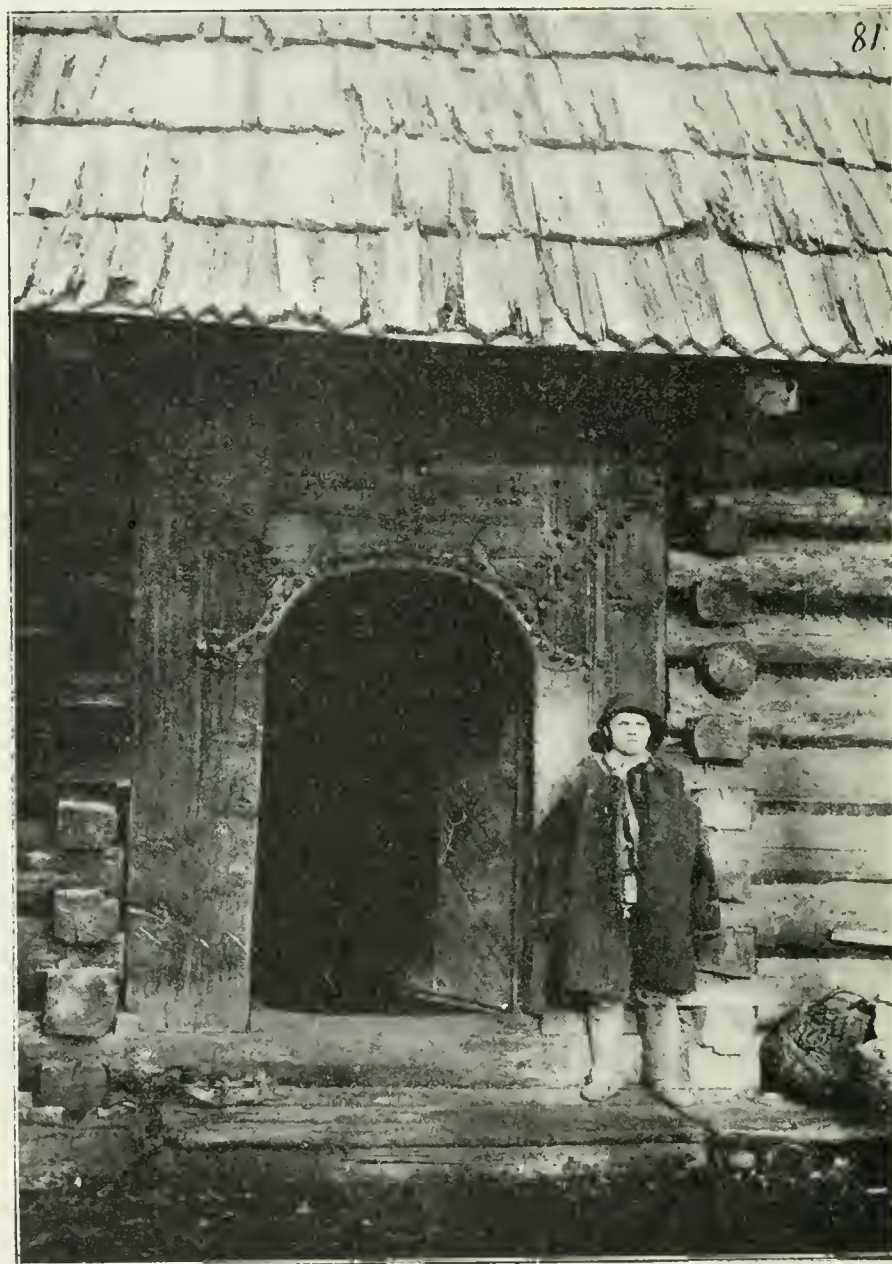
Ryc. 92. Stare „dźwirze“ w Zakopanem, z widocznym na odrzwiach Kolkowaniem. (z fotografum).
