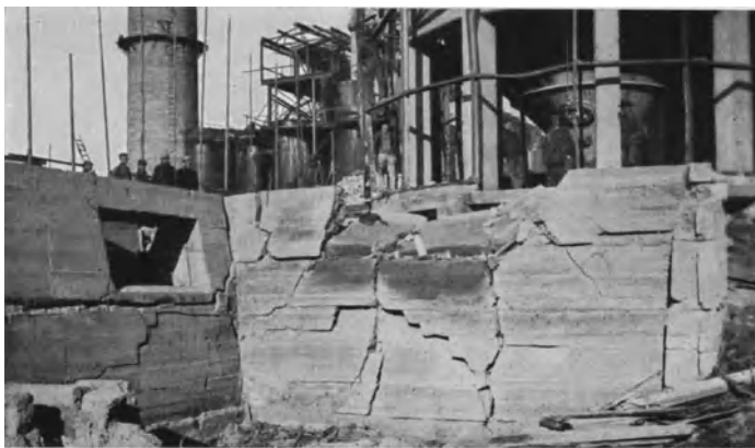
Abb. 1. Verhalten von Stampfbeton.
