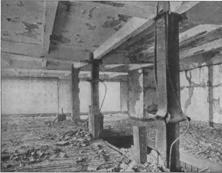
Abb. 77. Das Verhalten von Stahl bei großen Feuern.
