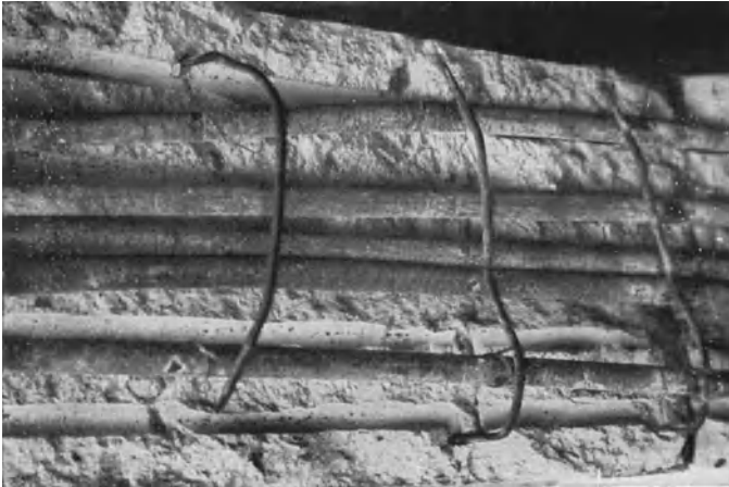
Abb. 62. Eiseneinlagen an der inneren Leibung einer Rahmenecke eines durch eine Explosion zerstörten Dachbinders. (Streckfiguren an den ausgebogenen Eisern, Gesprengte Bügel.)
