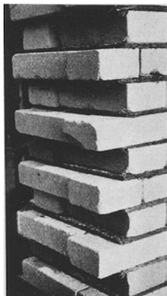
Bild 4. Novadom-Bauweise. Mörtelloses Mauerwerk (Lagerfugen mit Holzwollplatten)
