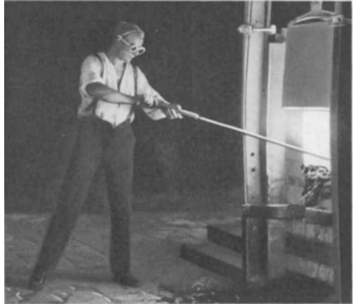
Abb. 64. Die Wärmeschutzbrille im Gebrauch vor dem Glasschmelzofen. (Nach C. Zeiß, Jena.)
