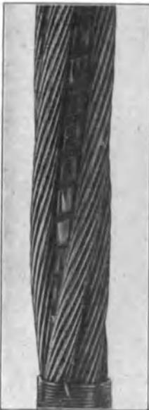
Fig. 13. Mit Eisenband umwickelte Hanfseele.
