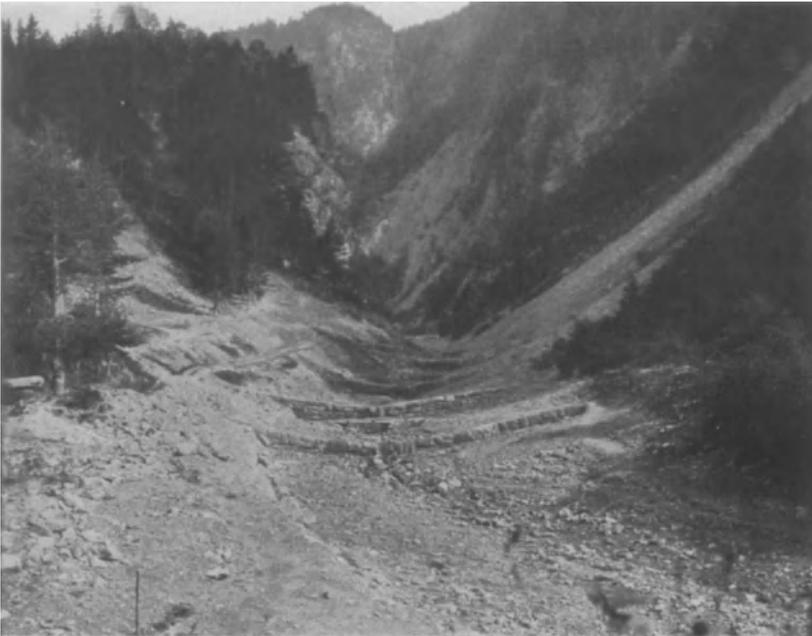
Abb. 15. Niedrige Quermauern im Wurnitzgraben bei Oberdrauburg, Kärnten. Die mäßige Einrensung ließ hohe Talsperren vermeiden; man beachte die wasserverteilende, verhältnismäßig große Breite der Abflußräume der Krone und die hoch, aber sanft aufgezogenen Flügel. Lichtbildersammlung des Geologischen Institutes der Technischen Hochschule in Wien.
