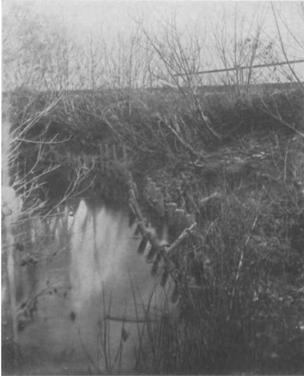
Abb. 24. Uferanbruch am Urflusse unterhalb St. Peter i. d. Au (N. Ö.). Die Pfähle des Flechtwerkes und der Spreitslagen werden durch den andauernden, schräg in die Tiefe arbeitenden Schurf allmählich ihres Haltes beraubt und neigen sich in den Uferkolk hinein. Eigenaufnahme.
