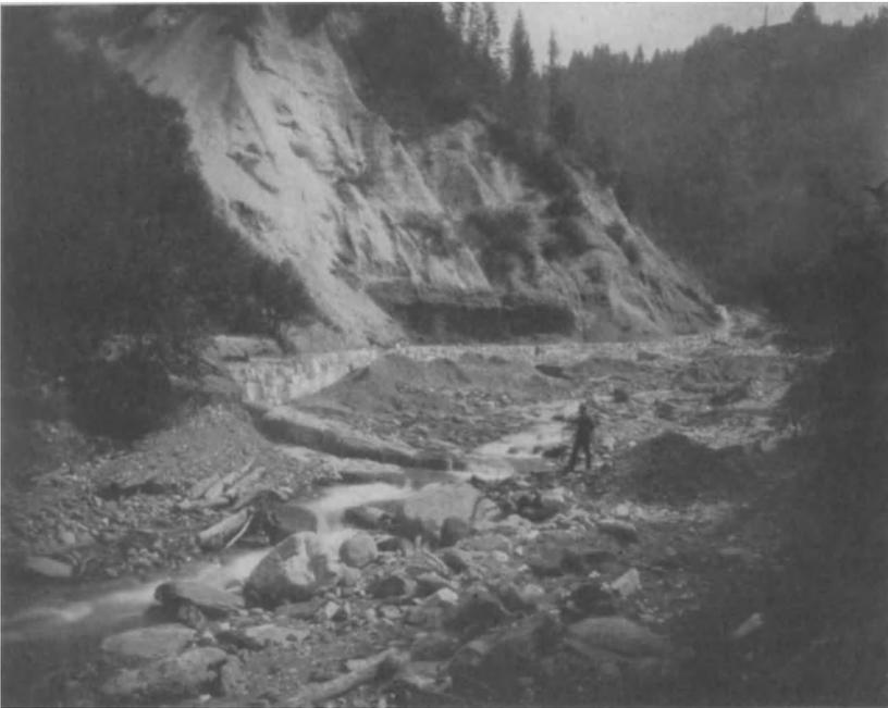
Abb. 19. Uferanbruch im Siflitzgraben, Kärnten. Unterhöhlung und Nachbrechen der widerstandsfähigeren Schichten. Uferschutz durch Leitwerke zwischen niederen, gemauerten Grundschwellen. Lichtbildersammlung des Geologischen Institutes der Technischen Hochschule in Wien.
