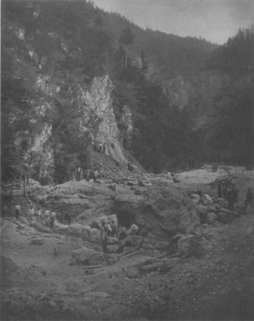
Abb. 21. Unterfahrung und Einbau eines großen Felsblockes in eine Sperrmauer. Silbergraben, Kärnten. Lichtbildersammlung des Geologischen Institutes der Technischen Hochschule in Wien.
