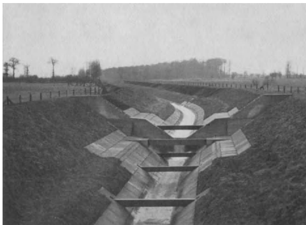
Abb. 91. Wasserbremsen. (Nach Ramshorn.)
