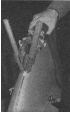
Abb. 70. Elektrodenhalter für das Weibverfahren.
