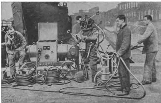
Abb. 351 Elektro-Unterwasserschweiß- und -schneideinrichtung.
