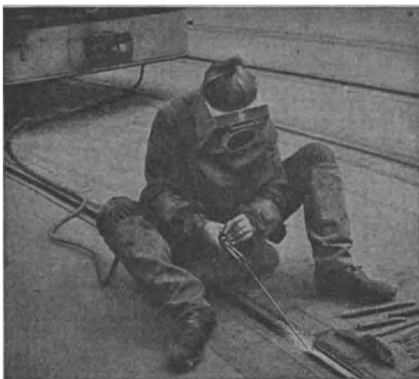
Abb. 147. Schweißer mit Schweißgerät (beim Schienen-aufschweißen).
