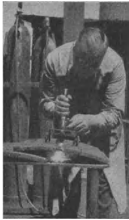
Abb. 7. Das Brennschneiden.
