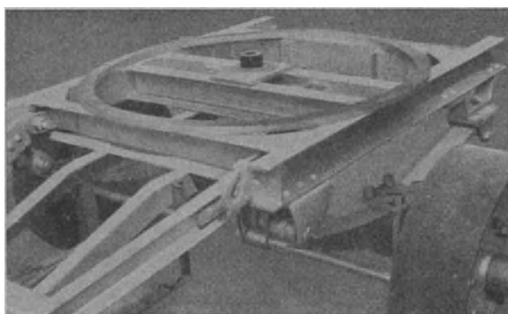
Abb. 271. Drehgestell eines Lastwagenanhängers.
