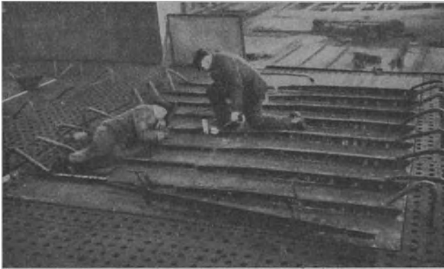
Abb. 284. Schweißen eines Schotts auf der Spannplatte.
