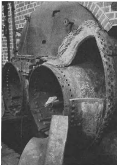
Abb. 246. Zur Schweißung vorbereiteter Dampfkesselboden.
