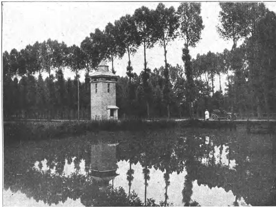
Abb. 64. E.W. Bergheim. Turm für je 2 Hochspannungsleitungen. Architekt: W. Issel, A.E.G., Berlin.
