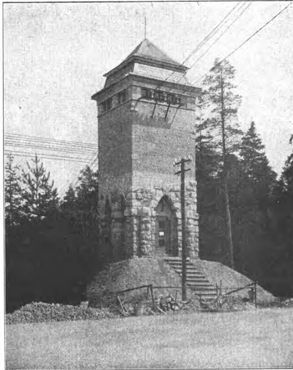
Abb. 63. Elbzentrale. Hochspannungsturm für den Augustusberg Gottleuba. Aus dem Ort entnommener Sandstein, für hervorragenden Aussichtspunkt erbaut. Architekt: W. Issel, A.E.G., Berlin.
