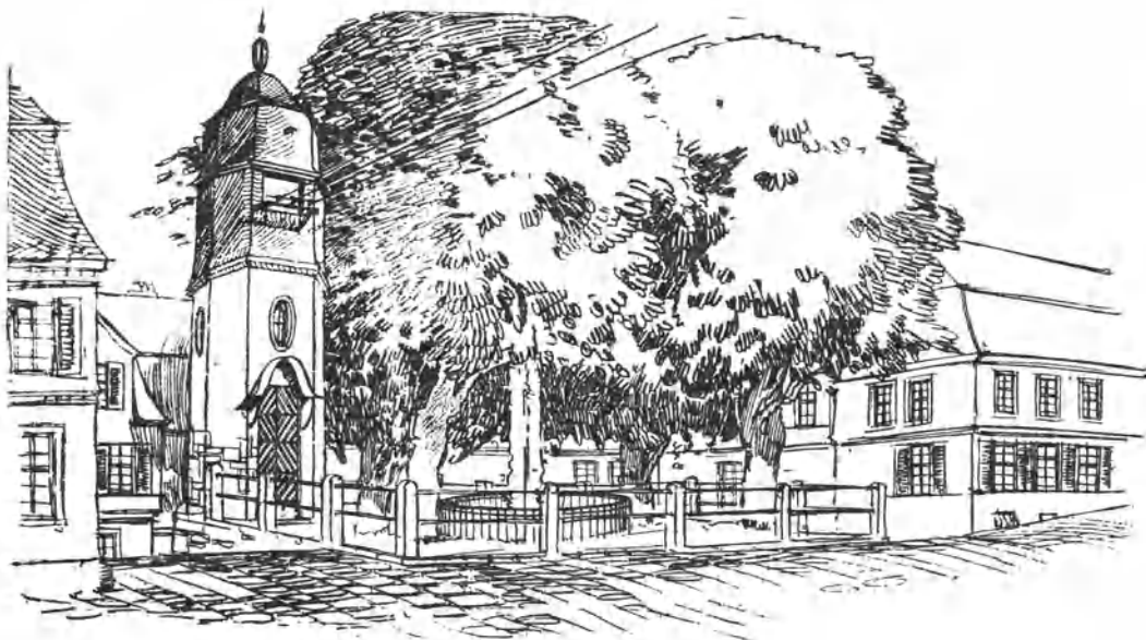
Abb. 50. E.W. Obererzgebirg. Turm für Kabeleinführung und Niederspannungsausführung für den Schloßplatz zu Schwarzenberg. Dem Standpunkt und der Umgebung durch Wahl der Bauformen und Materialien angepaßt. Architekt: W. Issel, A.E.G., Berlin.
