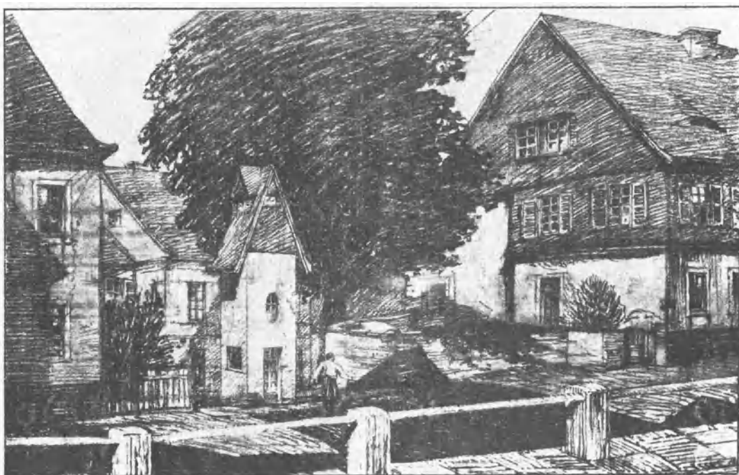
Abb. 55. U.C. Gotha. Kabelstation mit Niederspannungsabgang für Suhl. Die Station liegt zwischen 2 steil ansteigenden Straßen u. ist geputzt u. geschiefert wie die Nachbarhäuser. Architekt: W. Issel, A.E.G., Berlin.
