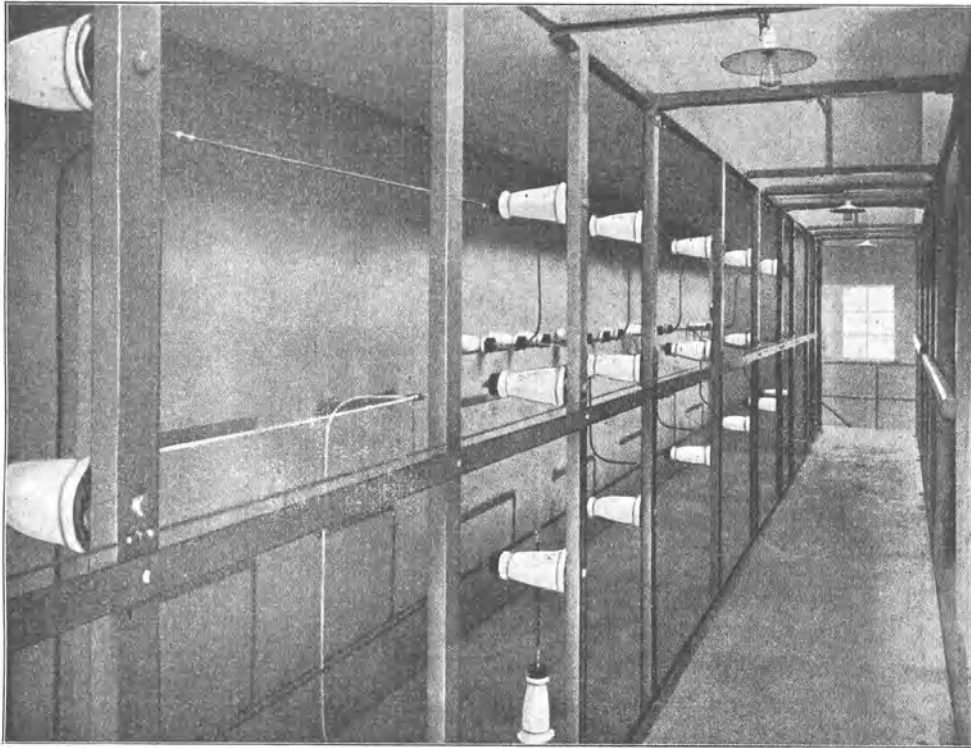
Abb. 14. Anordnung von Hochspannungssammelschienen.
