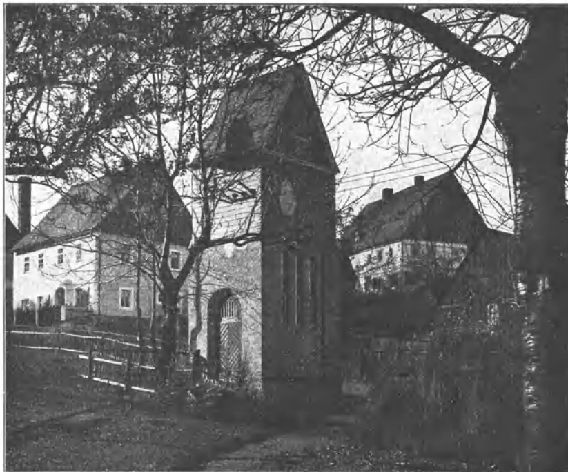
Abb. 58 u. 59. E.W. Obererzgebirg. Normale Station für eine Hochspannungsausführung, durch Schieferung und Schalung dem Ortsbilde angepaßt. Architekt: W. Issel, A.E.G., Berlin.
