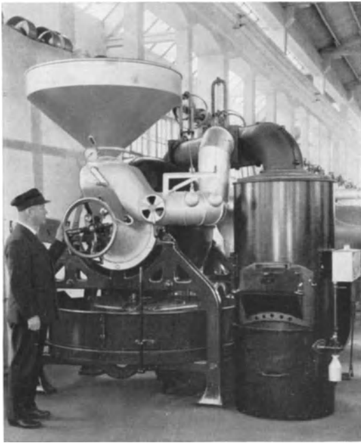
Abb. 9. Schnellröster mit Koksgaserzeuger, Bauart Sirocco von G. W. Barth.
