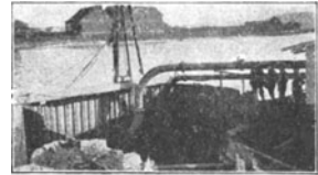
Walzeiserne Ransome-Spundwand verwendet für Fangedamm Nietlos! Wasserdicht!
