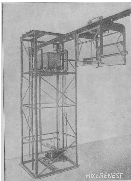
Abb. 11 und 12. Sende- und Empfangsstationen der Elektropost von Mix & Genest beim Zentralbriefpostamt in München.
