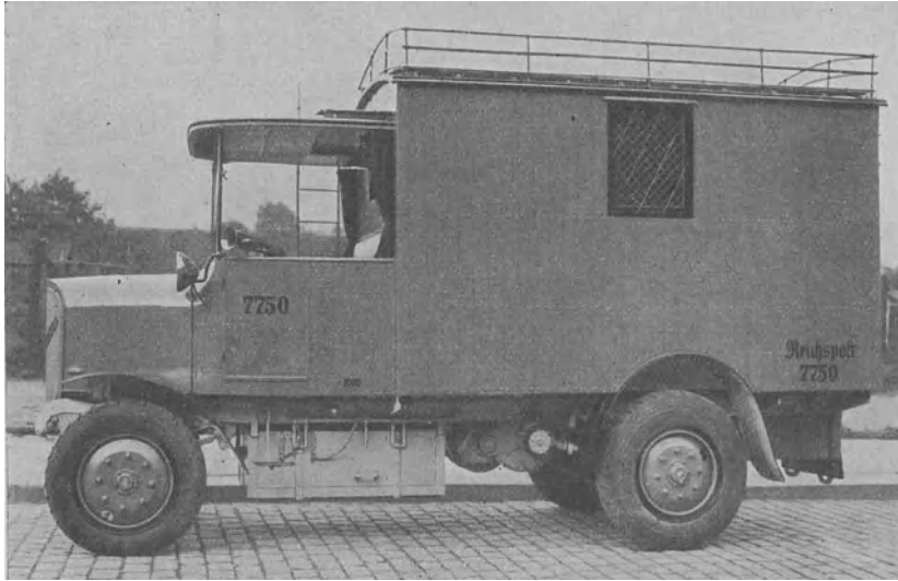
Abb. 7. Elektrischer Zweitonner für den Stadt- und Vorortverkehr.
