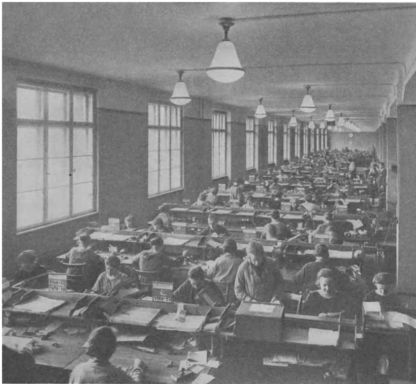
Abb. 1. Beleuchtung mit hochkerzigen Lampen.
