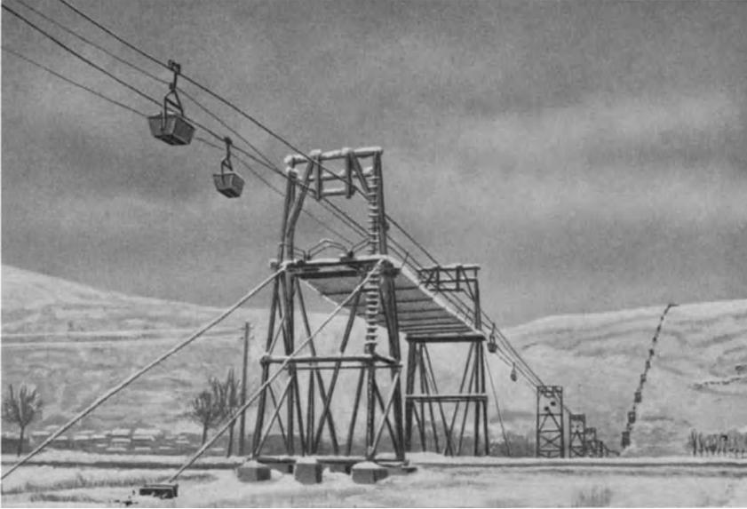
Abb. 184. Schutznetz auf Holzstützen (Heckel).
