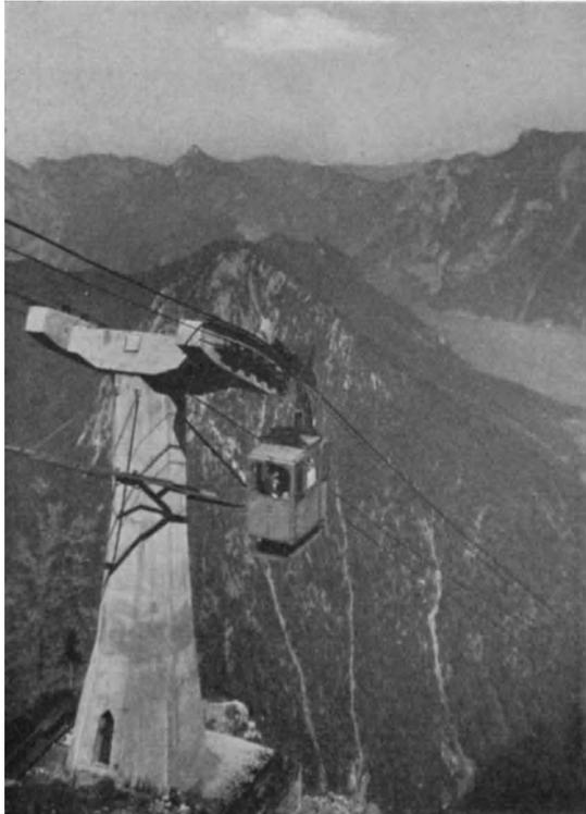
Abb. 179. Eisenbetonstütze der Ebensee-Bahn (Bleichert).
