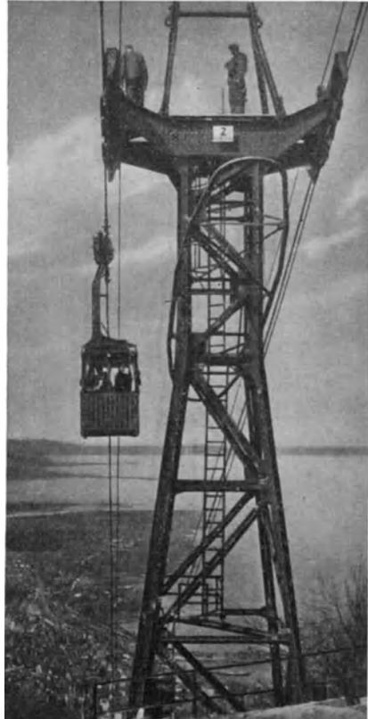
Abb. 181. Führungsbügel der Pfänderbahn (Bleichert).
