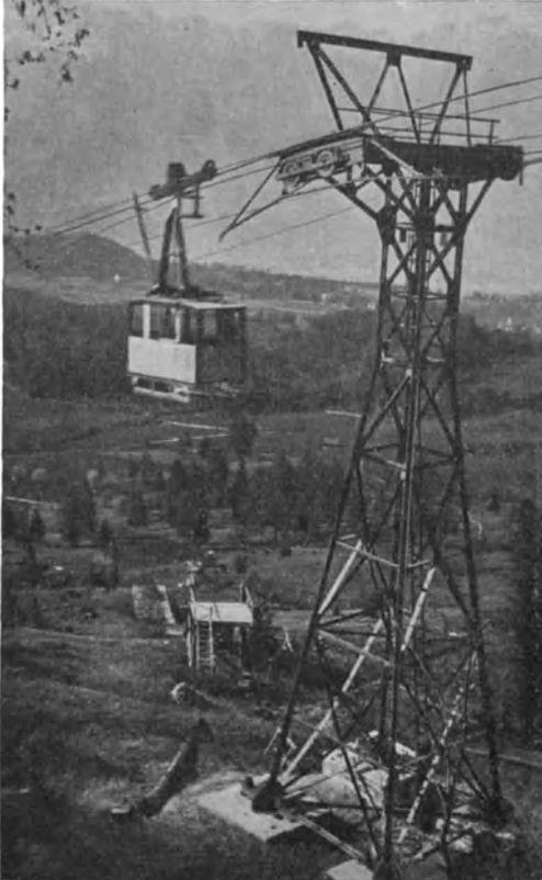
Abb. 180. Eiserne Stütze der Patscherkofelbahn (Bleichert).
