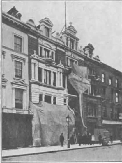
Abb. 9. Schutz der Umgebung beim Abstrahlen der Häuserfronten (Durlach.)
